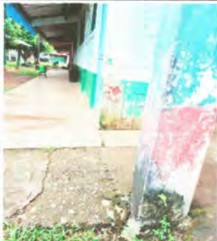
Foto 7: Pintura en muros exteriores e interiores
