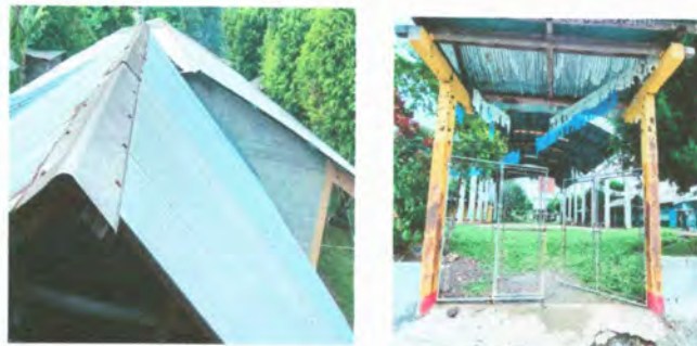
Foto 2: Sustitución de capote de lámina para lámina troquelada
