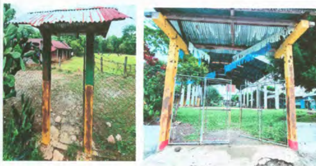
Foto 6: Sustitución de portón de metal por metal
