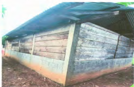
Foto 3: mejoramiento de pared de madera por block de cocina
