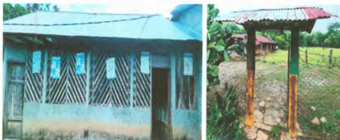
Foto 1: sustitución de lámina por lámina troquelada
