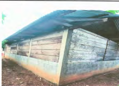
Foto 8: reparación de pared con solera y columnas
