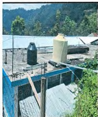
Foto 9. Depósito de agua instalado para abastecer los baños y lavamanos.
