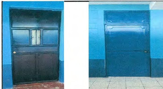
Foto 3. Puertas pintadas en los módulos 1, 2, 3 y 4.
