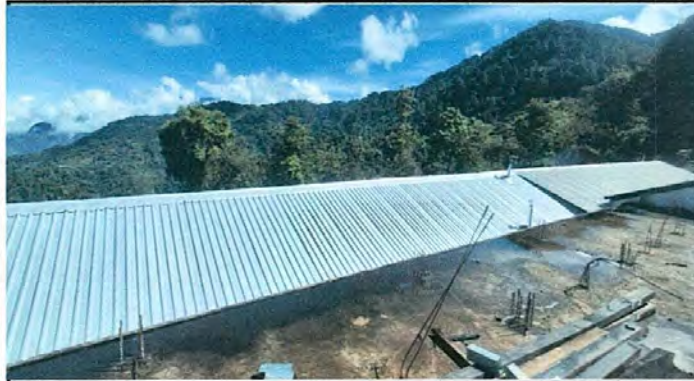
Foto 1. Techo nuevo instalado.
