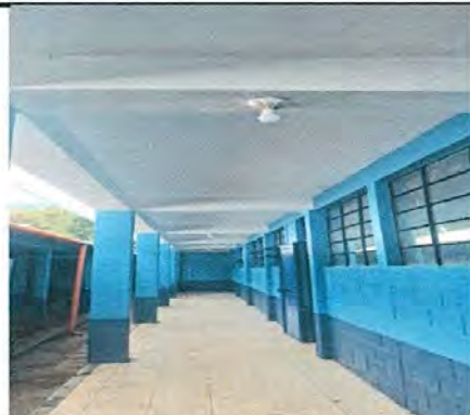
Foco 8. Focos ahorradores instalados en el módulo 2.
