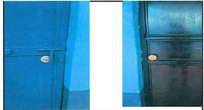
Foto 4. Chapas nuevas colocadas en cada puerta.
