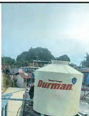
Foto 9. Depósito de agua instalado para abastecer los baños y lavamanos.
