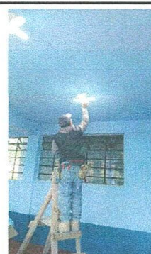
Foto 4: sustitución de focos led
