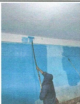
Foto 3: pintura en muros exteriores e interiores
