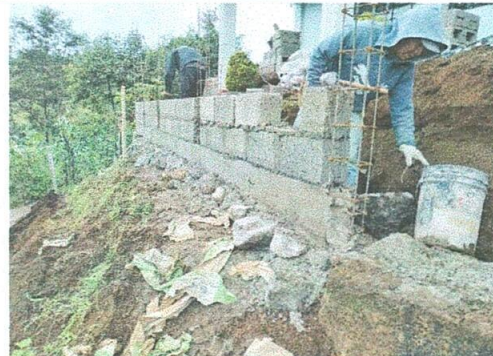
Foto 2: reparación de muro perimetral
