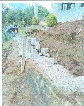
Foto 5: reparación de muro de contención
