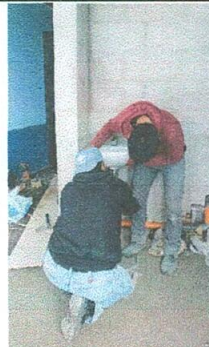
Foto 6: sustitución de lavamanos en servicios sanitarios
