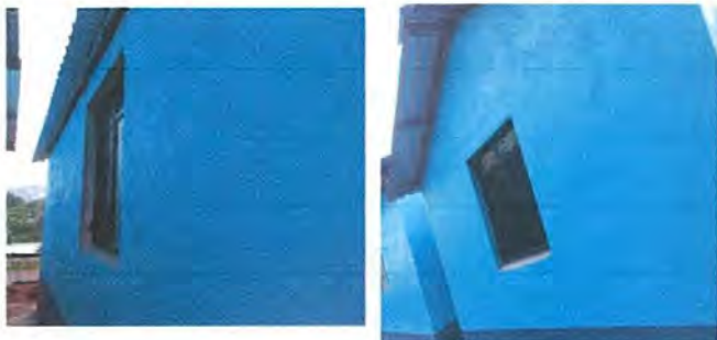
FOTO No. 13. ya estan las ventanas de metal
