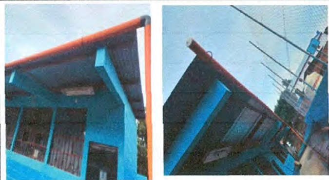
FOTO No. 3 estan colocando los tubos PVC
