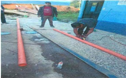
FOTO No. 3 estan colocando los tubos PVC
