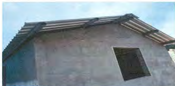
FOTO No. 13 ya estan quitando las ventanas
