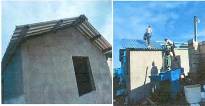
FOTO No. 1 estan cambiando las lamina
