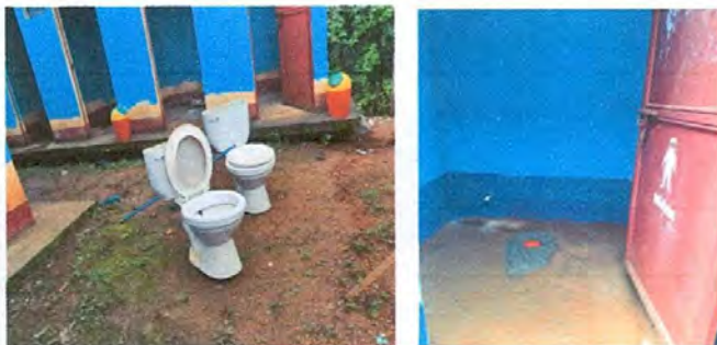
FOTO No. 5 ya estan colocando los inodoros
