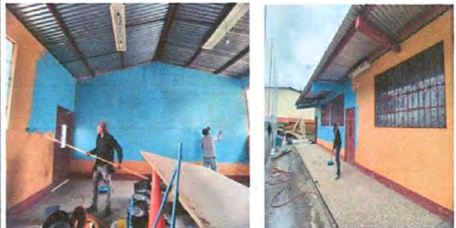
FOTO No. 4 estan pintadno las paredes
