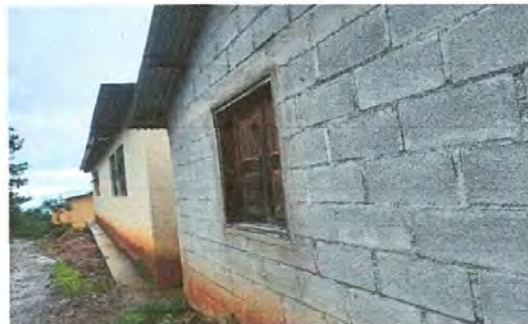
FOTO No. 12: las paredes de la cocina estan en malas condiciones ya que en tiepo de lluvia humedece, por eso se ve la nesecidad de repellar.
