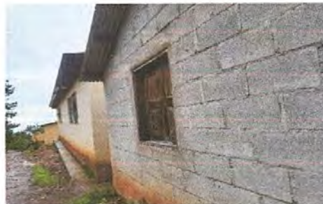
FOTO No. 12: las paredes de la cocina estan en malas condiciones ya que en tiepo de lluvia humedece, por eso se ve la nesecidad de repellar.
