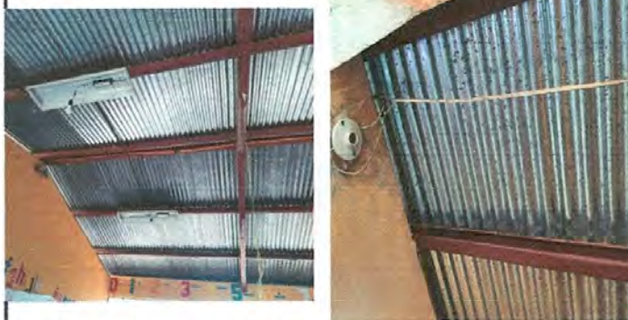
FOTO No. 8: el cableado del sistema electrico de las aulas y cocina estan en mal estado.
