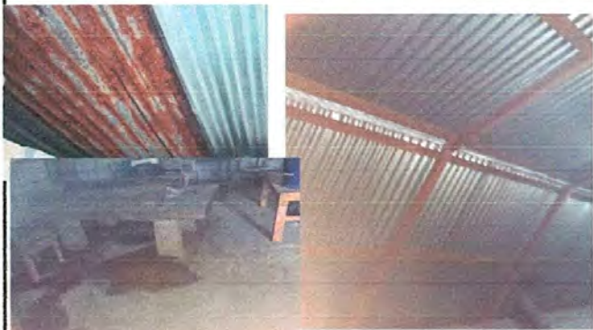
FOTO No. 1: El techo de la cocina esta en malas condiciones ya que en tiempo de lluvia ya entra agua y todas las laminas tienen agujeros por eso se ve la necesidad en cambiarlas y las maderas de soporte ya no estan en
