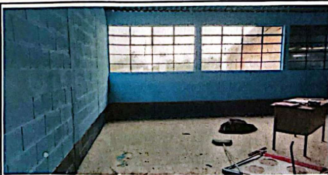
Foto 5: pintura de muros internos
