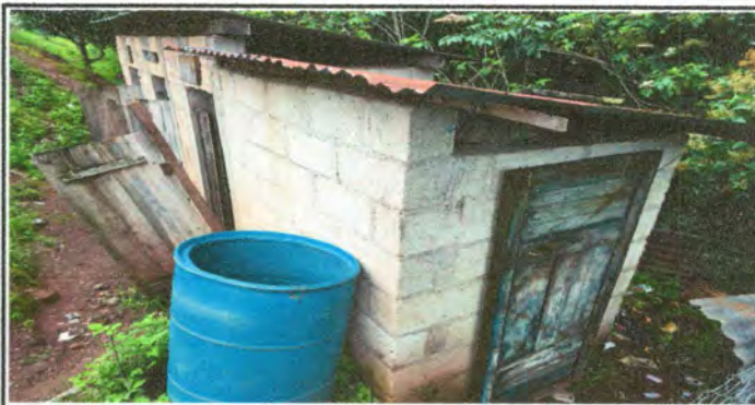
Foto 4: sustitución de puerta en servicios sanitarios
