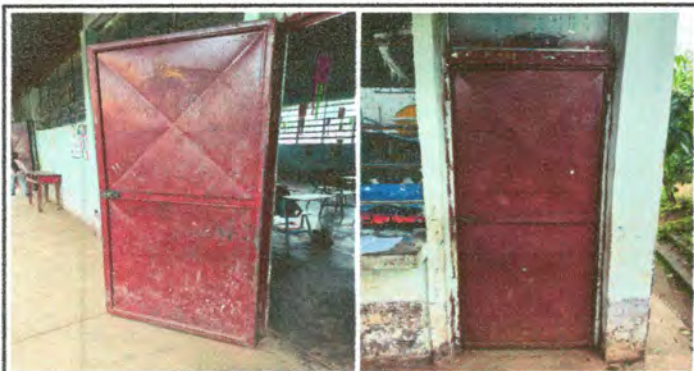
Foto 3: sustitución de puertas de aulas
