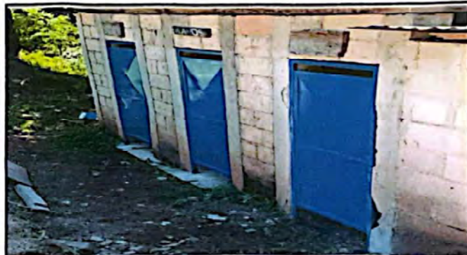
Foto 4: sustitución de puerta en servicios sanitarios
