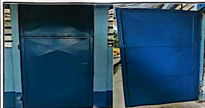
Foto 3: sustitución de puertas
