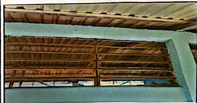
Foto 5: sustitución de vidrios
