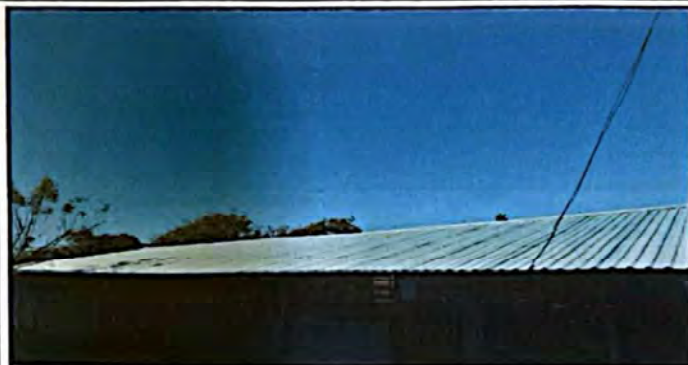
Foto 1: sustitución de laminas, por lamina troquelada aluzinc calibre 26
