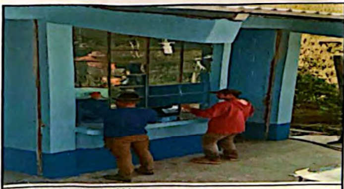
Foto 5: sustitución de vidrios
