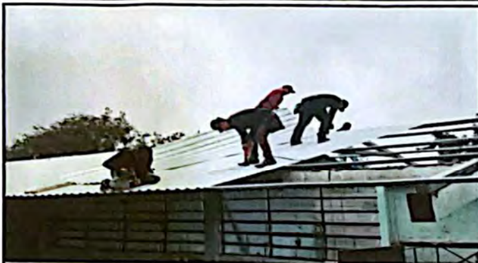
Foto1: sustitución de laminas, por lamina troquelada aluzinc calibre 26
