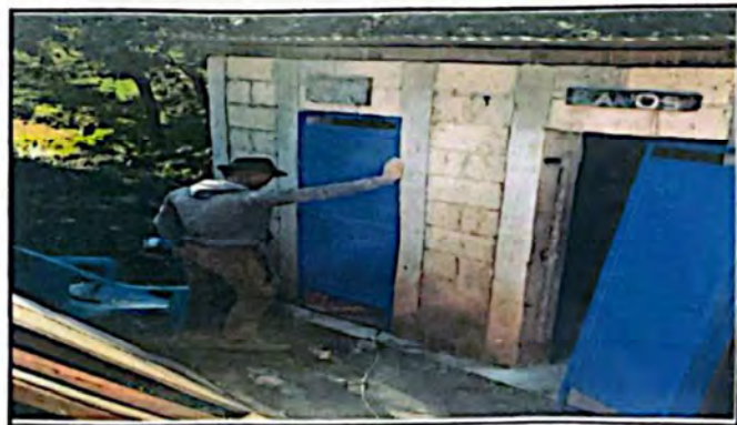
Foto 4: sustitución de puerta en servicios sanitarios
