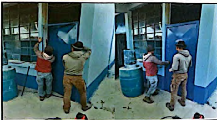
Foto 3: sustitución de puertas
