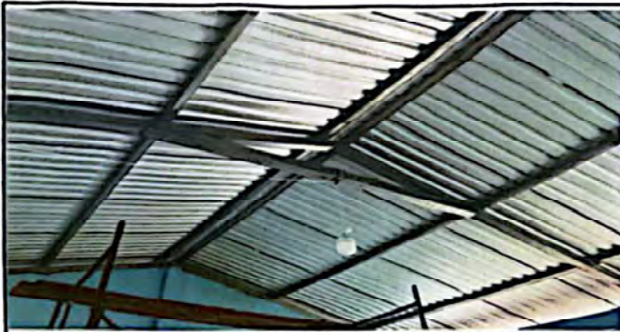
Foto 7: sustitución de focos ahorradores
