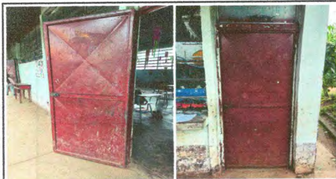
Foto 3: sustitución de puertas de aulas
