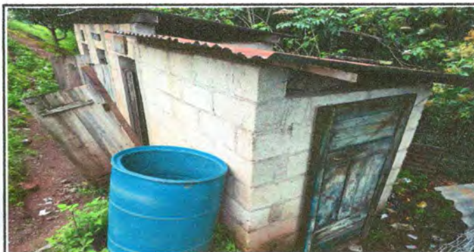
Foto 4: sustitución de puerta en servicios sanitarios
