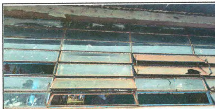
Foto 5: sustitución de vidrios
