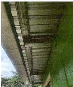
Foto 5: Estructura de soporte reemplazado
