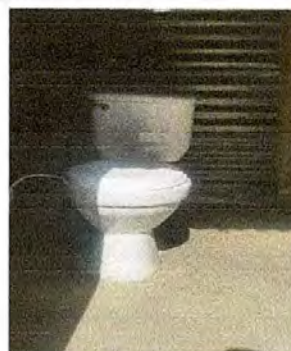
Foto 10: Sanitario nuevo instalado
