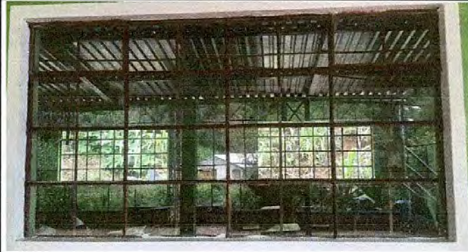
Foto 1: Finalización de colocación de ventanas
