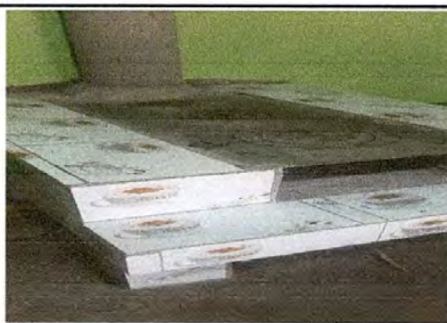
Foto 12: Estructura de piso de plancha rural restaurada
