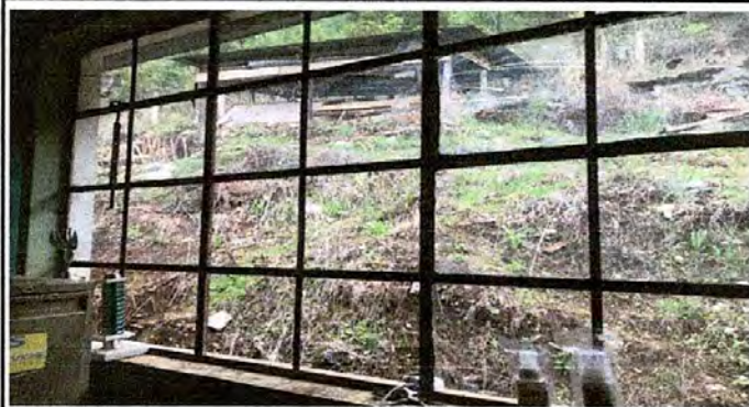
Foto 1: Sustitución de vidrio de ventana
