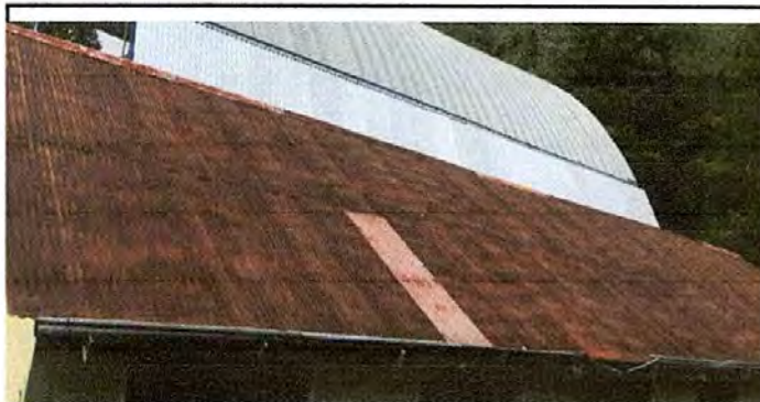
Foto 6: Laminas y clavos oxidados
