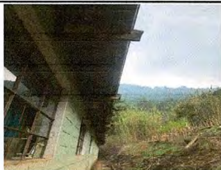
Foto 5: Estructura de soporte de madera en descomposición
