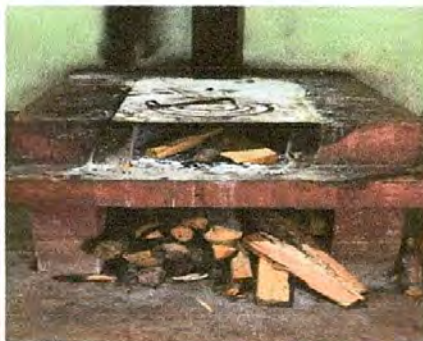
Foto 8: Plancha oxidada
