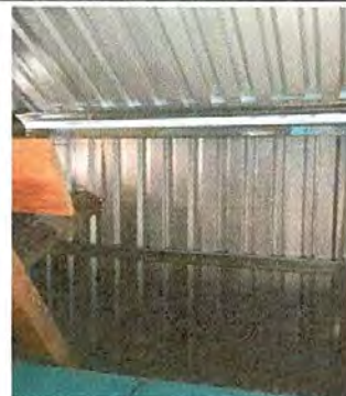
Foto 2: ESTRUCTURA DE TECHO DE COCINA
