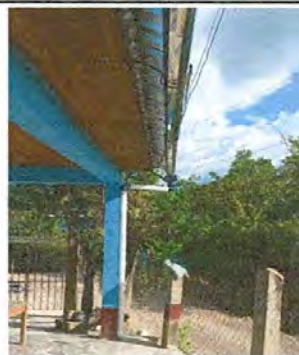
Foto 6: CANALES Y BAJADAS DE AGUA
