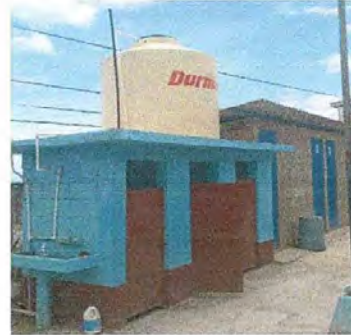
FOTO 12 DEPÓSITO DE AGUA
