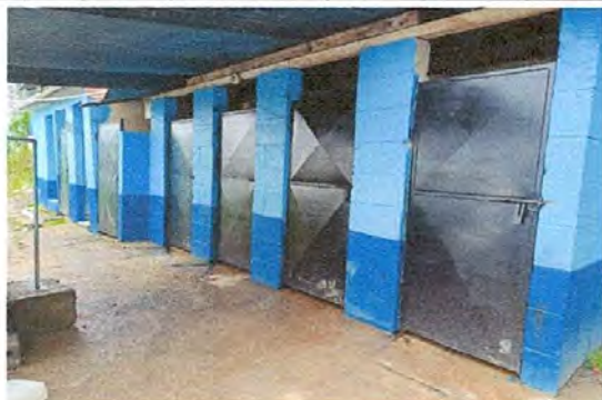
Foto 7: Mantenimiento a estructura de puertas de sanitario
