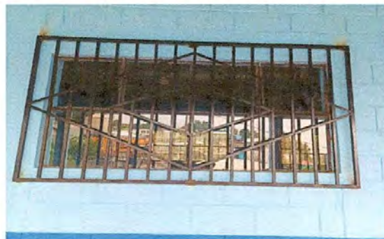
Foto 2: Sustitución de vidrios.
