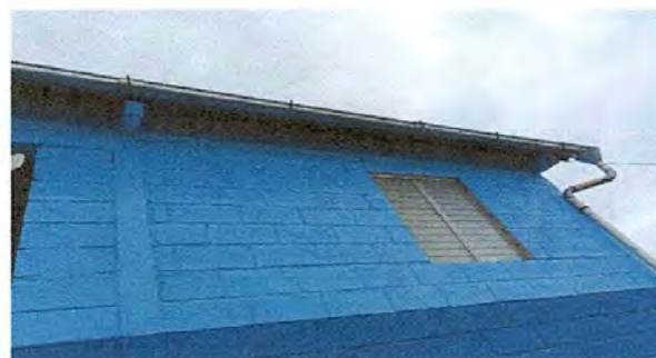
Foto 4: Sustitución de canal de metal
