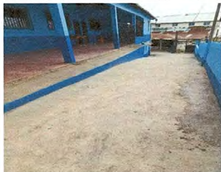
Foto 11: Reparación de plancha de concreto de patio
