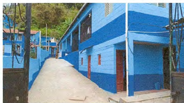
Foto 6: Pintura de muros exteriores e interiores
