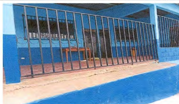
Foto 8: Mantenimiento a barandas de metal
