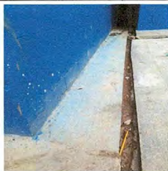
Foto 5: Reparacion de banqueta de concreto
