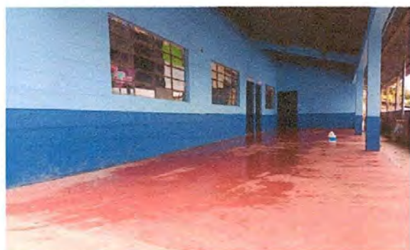
Foto 3: Sustitución de piso de torta de concreto
