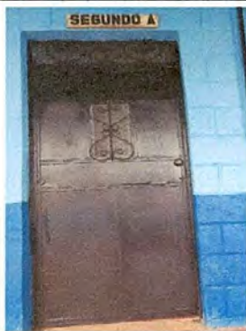
Foto 1: Mantenimiento a puertas de metal.
