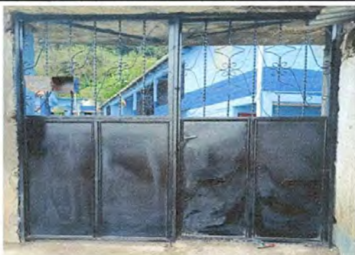
Foto 9: Mantenimiento a porton de metal
