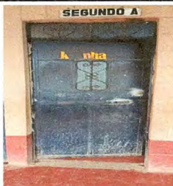
Foto 1: Mantenimiento a puertas de metal.
