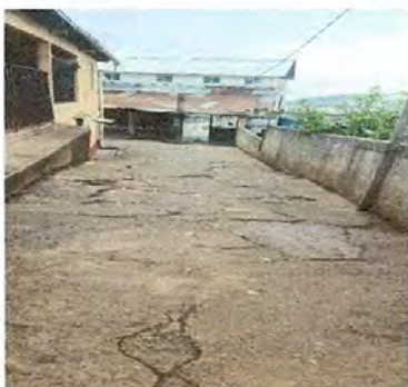
Foto 11: Reparación de plancha de concreto de patio
