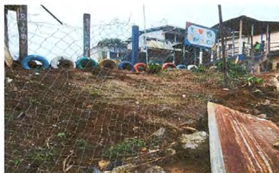
Foto 10: Reparación de muro perimetral con tubo hg y malla galvanizada
