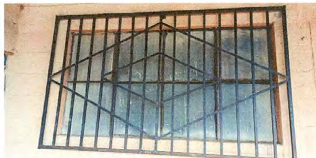
Foto 2: Sustitución de vidrios.
