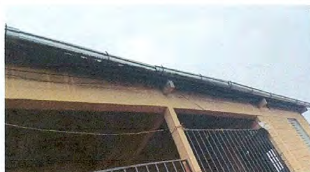
Foto 4: Sustitución de canal de metal
