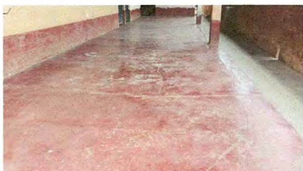
Foto 3: Sustitución de piso de torta de concreto
