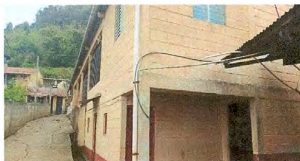
Foto 6: Pintura de muros exteriores e interiores
