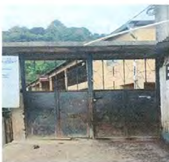
Foto 9: Mantenimiento a porton de metal
