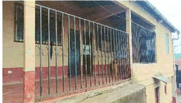
Foto 8: Mantenimiento a barandas de metal
