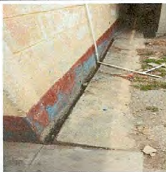
Foto 5: Reparación de banqueta de concreto
