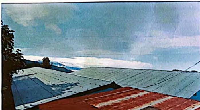
Foto 4: Sustitución de techo
