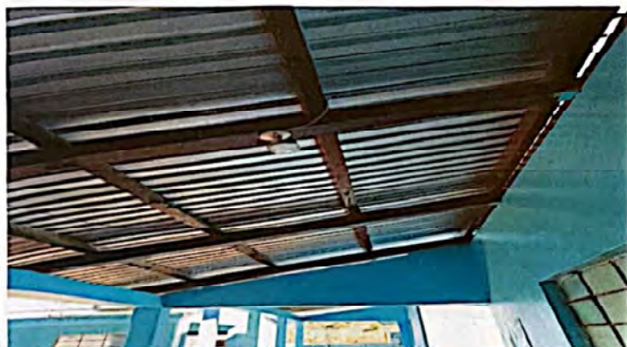
Foto 3: Reparación de sistema eléctrico
