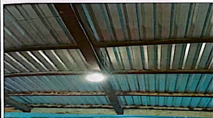
Foto 5: Reparación de sistema eléctrico.
