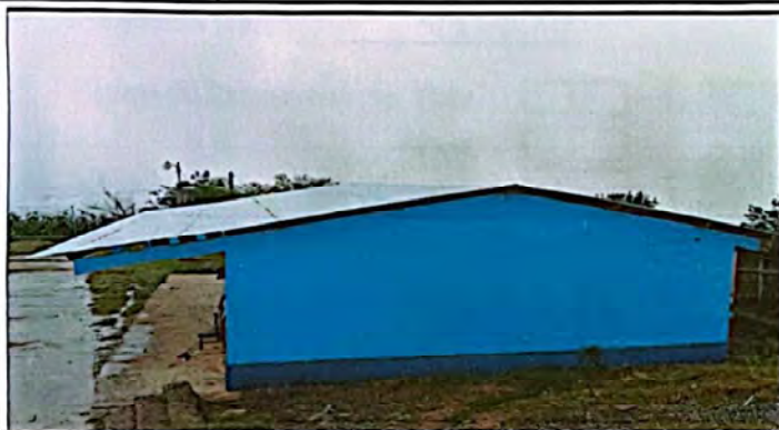
Foto1: Sustitución de Techo
