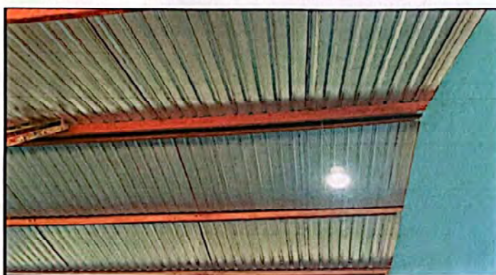
Foto 6: Reparación de sistema eléctrico.
