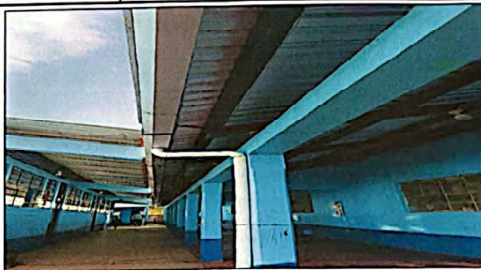
Foto 2: Reparación de canales de bajadas de agua
