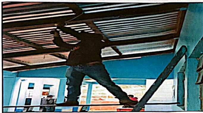
Foto 3: Reparación de sistema eléctrico
