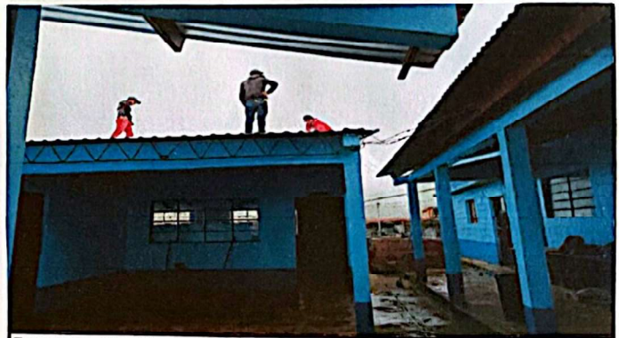
Foto 4: Sustitución de techo
