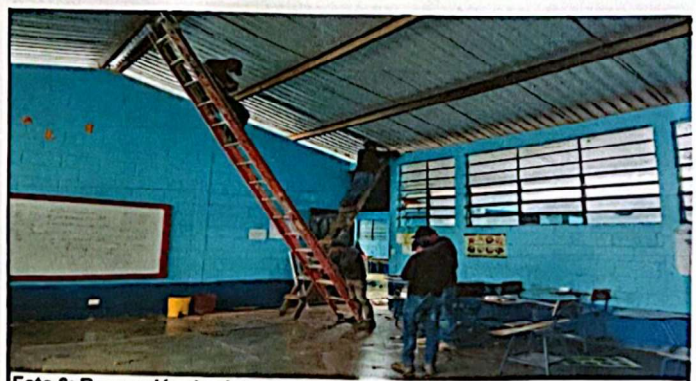
Foto 6: Reparación de sistema eléctrico.
