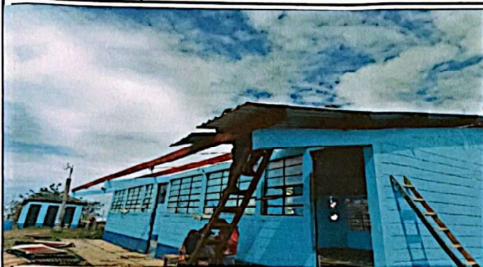
Foto 1: Sustitución de Techo
