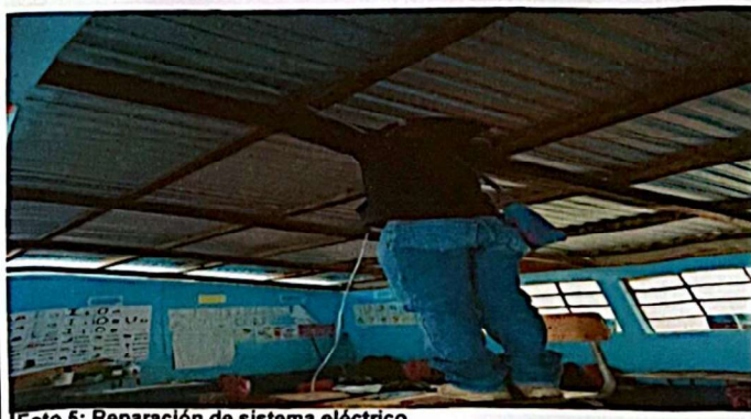
Foto 5: Reparación de sistema eléctrico.
