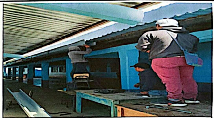
Foto 2: Reparación de canales de bajadas de agua
