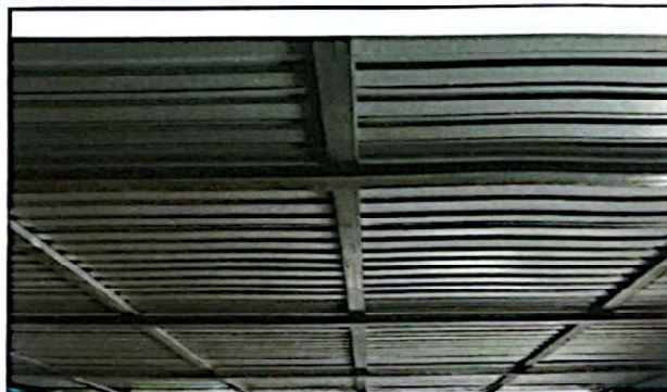
Foto 4: Vista de la estructura del módulo antiguo
