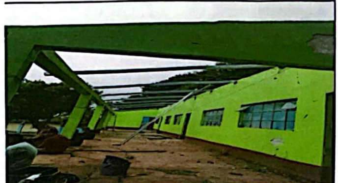
Foto 2: Vista del piso del edificio, módulo antiguo
