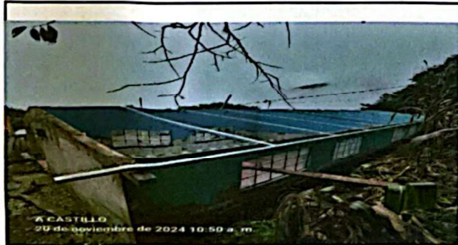
Foto 3: vista de la pared del edificio, módulo antiguo
