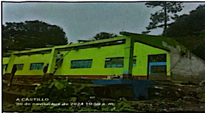
Foto 1: Vista de la fachada del edificio, módulo antiguo
