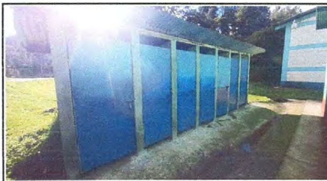
foto 4. Puertas instaladas en los servicios sanitarios
