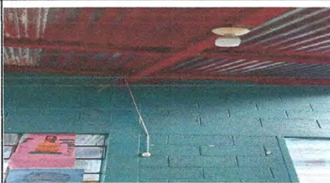
foto 8. Interruptor simple instalado
