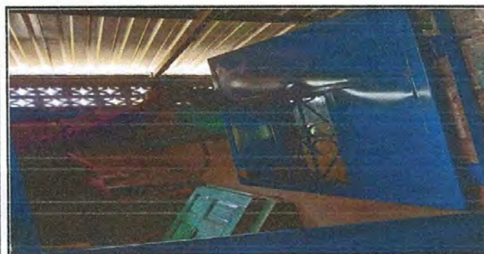
foto 5. Colocando la puerta
