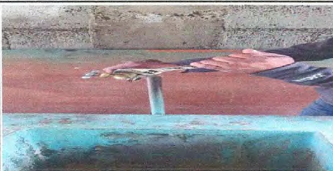
foto 9. Sustitución de lleve de chorro.
