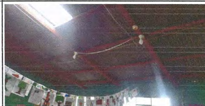
foto 10. Reparación de cableado eléctrico.
