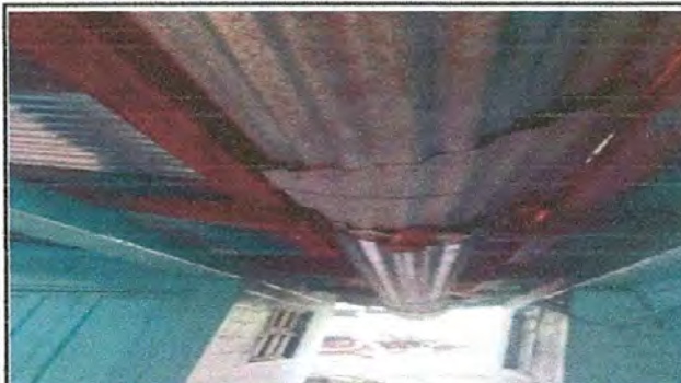
foto 6. Sustitución de canales
