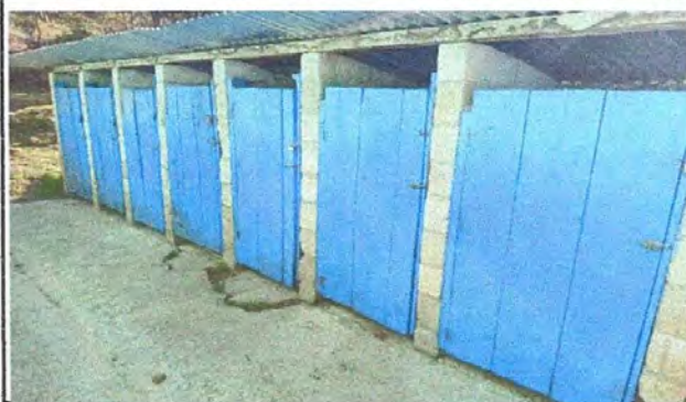
foto 4. sustitución de puertas
