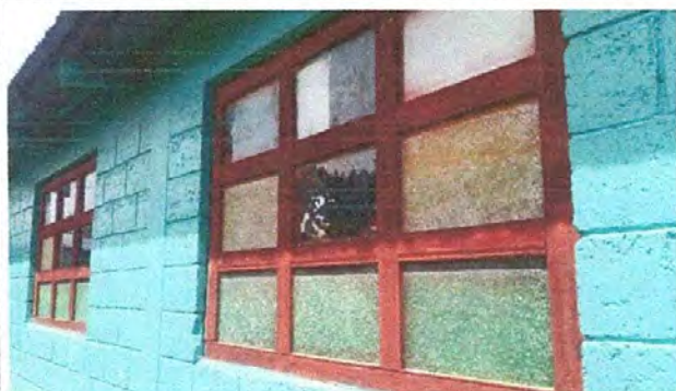
foto 3. sustitucion de ventanas
