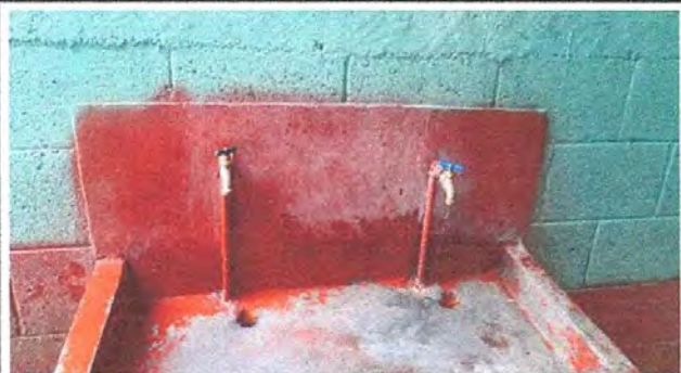
foto 9. Sustitución de lleve de chorro.
