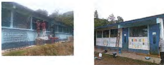
Foto No 3. colocación de balcones y pintada de muros exteriores e interiores
