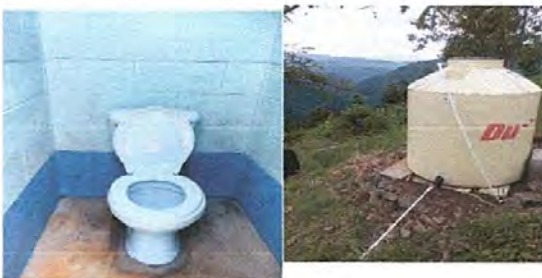
Foto 5: Sustitución de inodoro y depósito de agua
