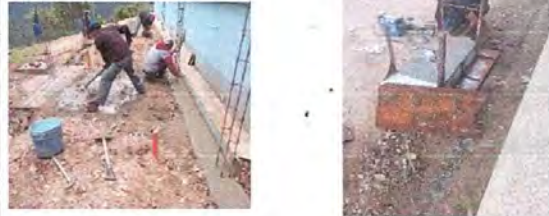
Foto No. 4 .Mejoramiento de cocina y sustitucion de plancha de 3 hornillas
