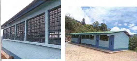
Foto 3: Colocación de balcones y pintada de las paredes de la escuela
