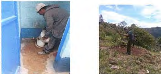
Foto 5: Sustitución de inodoro y deposito de agua
