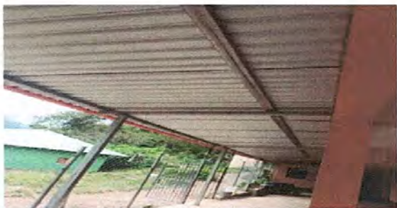
foto 5: entechado con lamina troquelada aluzinc
