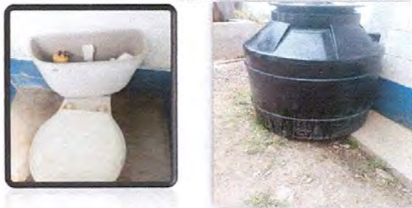
Foto 5: Sustitución de inodoro y depósito de agua
