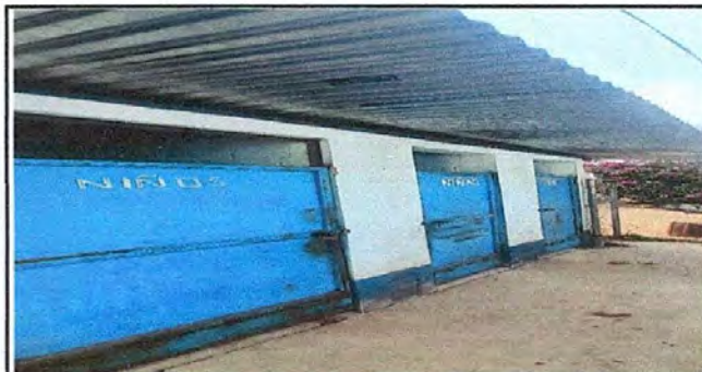
Foto 6: Cambio de puertas.
