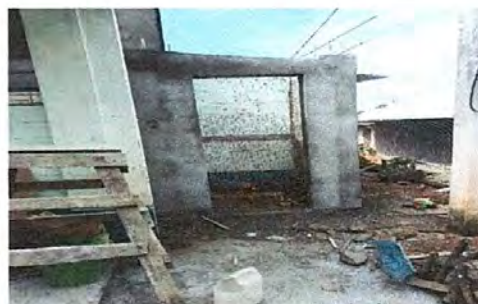
foto 6. Trabajo en los sanitarios del centro educativo
