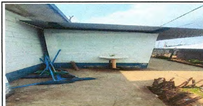
Foto 5: Pintar los tres baños del centro educativo
