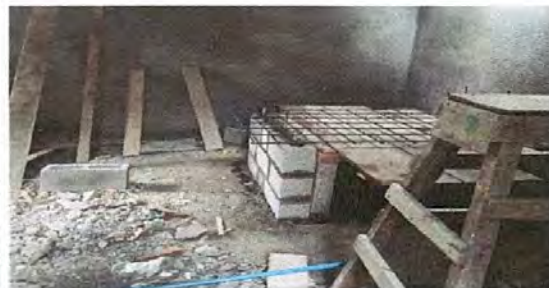
foto 2: construccion de la plancha de la conina,
