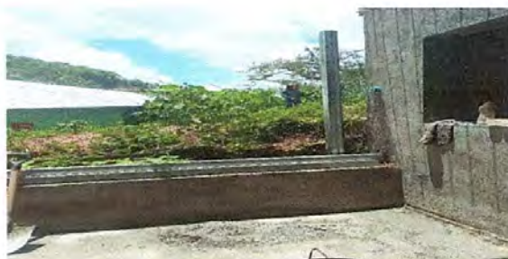
foto 5. Colocación de los tubos galvanizados para el entechado.
