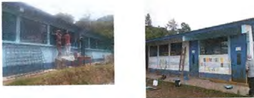
Foto No 3. colocación de balcones y pintada de muros exteriores e interiores
