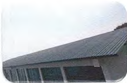
Foto 1. Pintada del techo de la escuela
