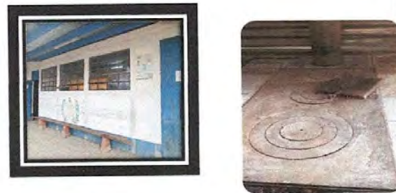
Foto 4: Pintada de la escuela y compra de nueva plancha de 3 ornillas
