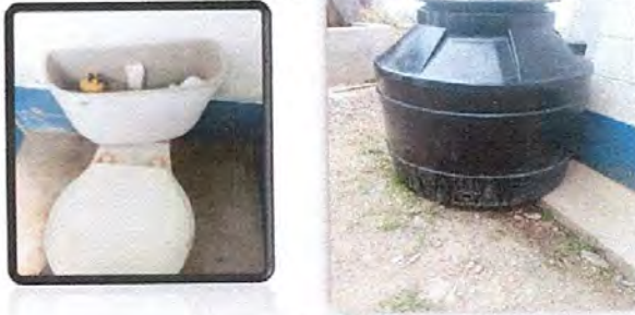
Foto 5: Sustitución de inodoro y depósito de agua
