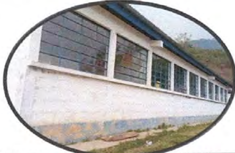
Foto 3: Colocación de balcones y pintada de las paredes de la escuela
