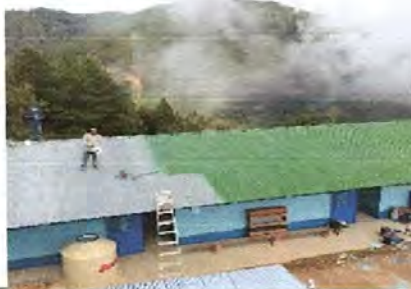
Foto 1. Pintada del techo de la escuela
