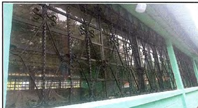
Foto 3: Ventanas balcón instaladas.
