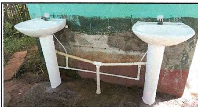
Foto 6: Lavamanos de porcelana instalados.
