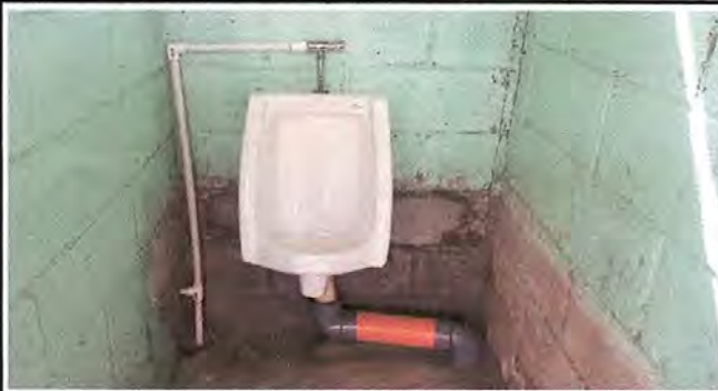
Foto 7: Mingitorio de porcelana instalado.
