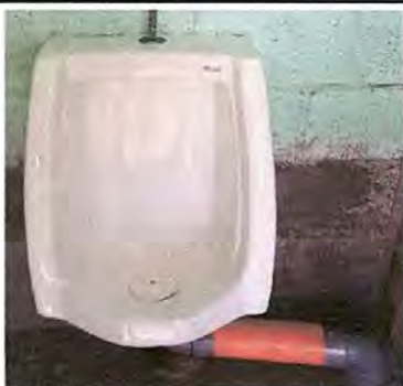
Foto 7: Instalación de mingitorio.
