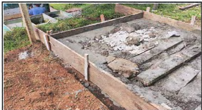
Foto 4: Construcción de base para instalación de depósito plástico para almacenamiento de agua.
