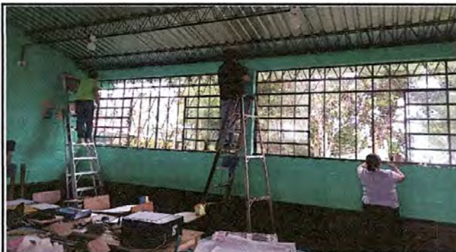
Foto 3: Instalación de ventanas balcón en las instalaciones del módulo 1.
