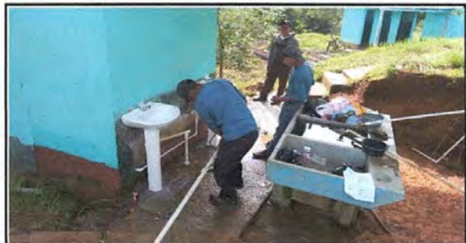
Foto 6: Instalación de lavamanos de porcelana.
