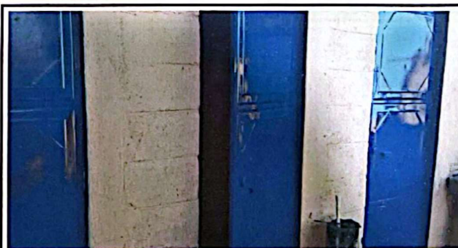
Foto 6: Puertas deterioradas por el oxido y desprendimiento de pintura.
