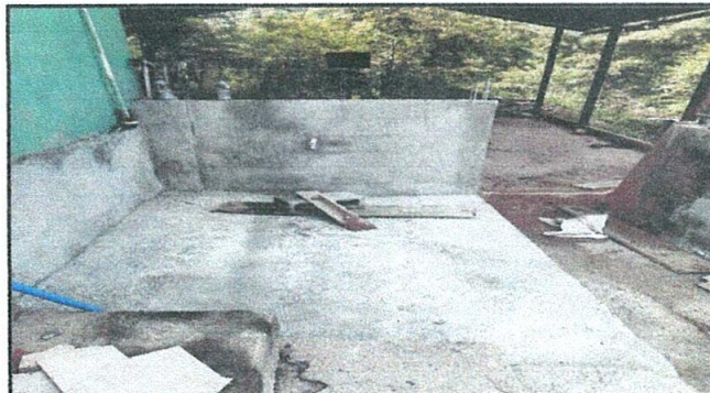
Foto 4: Sustrucción de pila de cemento de 2 lavaderos
