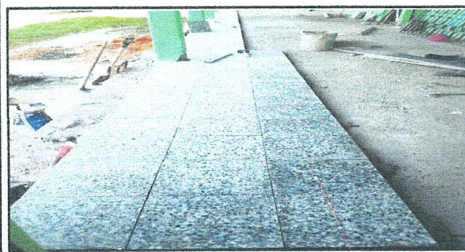
Foto 5: Sustrucción de piso de torta de un corredor por piso de granito
