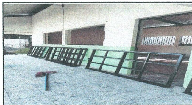
Foto 6: Mantenimiento de balcones de metal
