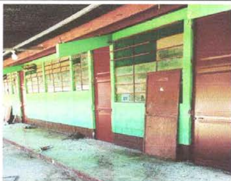
Foto 3: Sustitución de puerta
