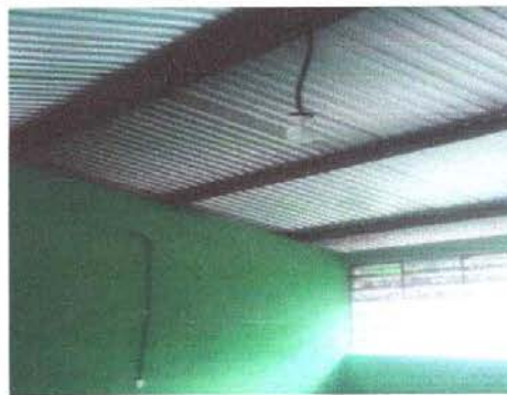
Foto 4: Sustitución de focos ahorradores, flaponeras, interruptores, toma corrientes, flípones, cableado eléctrico, ducto eléctrico + accesorios.
