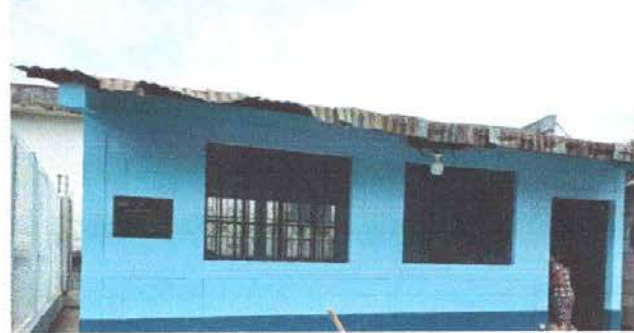
Foto 2: Pintura en muros exteriores e interiores.
