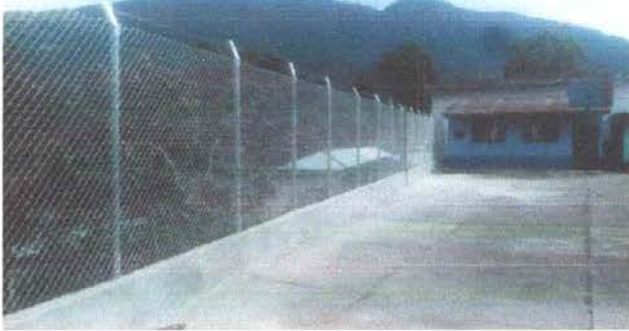
Foto 1: Reparación de muro perimetral de block con tubo hg y malla galvanizada, soleras intermedias y columnas
