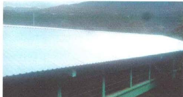
Foto 2: Sustitución de lámina por lámina troquelada aluzinc calibre 26 y sustitución de capote
