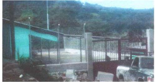
Foto 2: Reparación de muro perimetral de block con tubo hg y malla galvanizada, soleras intermedias y columnas
