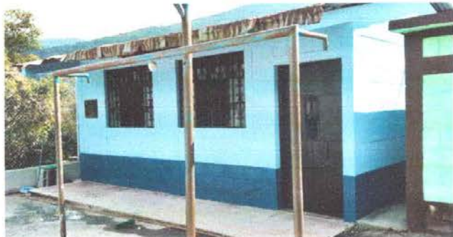
Foto1: Pintura en muros exteriores e interiores.
