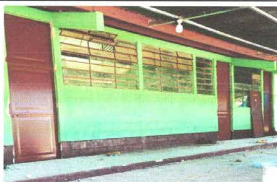
Foto 4: Sustitución de puerta
