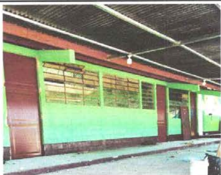
Foto 5: Estructura de techo: Sustitución de estructura de soporte de madera por metal.
