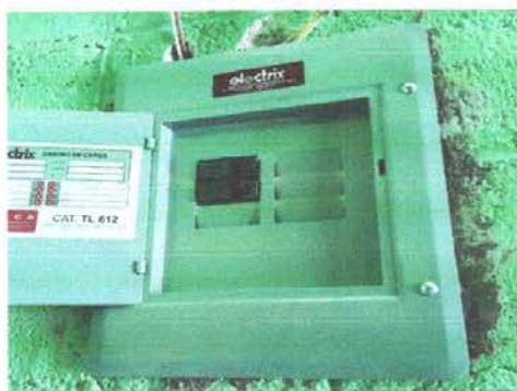
Foto 3: Sustitución de focos ahorradores, flaponeras, interruptores, toma corrientes, flípones, cableado eléctrico, ducto eléctrico + accesorios.
