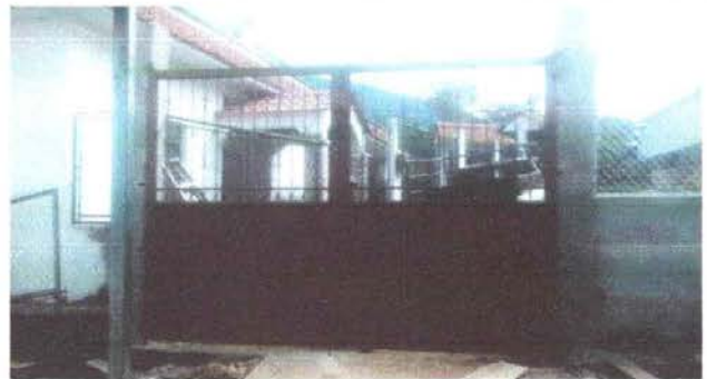
Foto 4: Sustitución de portón de metal
