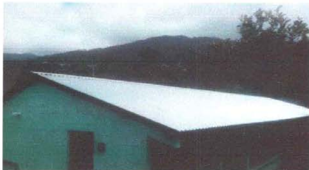
Foto 1: Sustitución de lámina por lámina troquelada aluzinc calibre 26 y sustitución de capote
