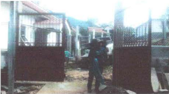
Foto 3: Sustitución de portón de metal
