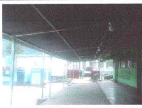
Foto 6: Estructura de techo: Sustitución de estructura de soporte de madera por metal.
