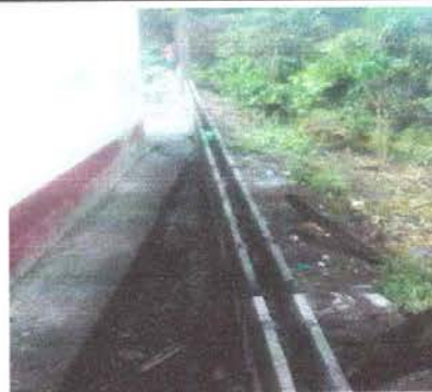
Foto 2: Reparación de muro perimetral de block con tubo hg y malla galvanizada, soleras intermedias y columnas
