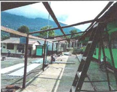
Foto 6: Sustitución de estructura de soporte de madera por metal.
