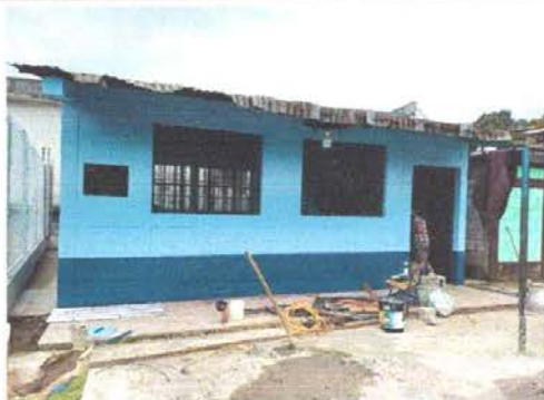
Foto1: Pintura en muros exteriores e interiores.
