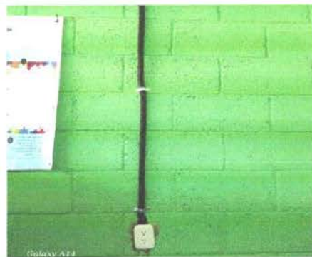
Foto 4: Reparación de sistema eléctrico: Sustitución de focos ahorradores, flaponeras, interruptores, toma corrientes, flipones, cableado eléctrico, ducto eléctrico + accesorios.
