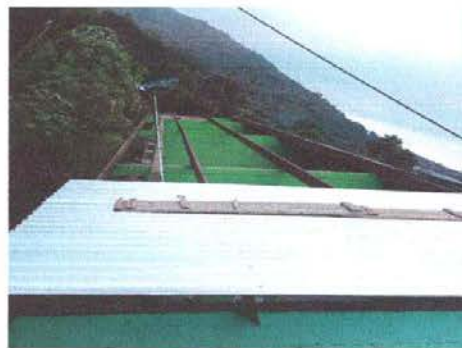
Foto 2: Sustitución de lámina por lámina troquelada aluzinc calibre 26 y sustitución de capote
