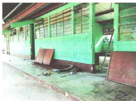
Foto 3: Sustitución de puerta
