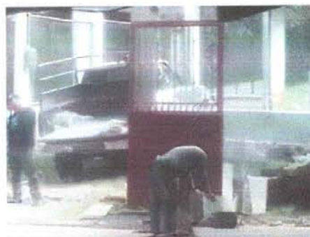
Foto 4: Sustitución de portón de metal
