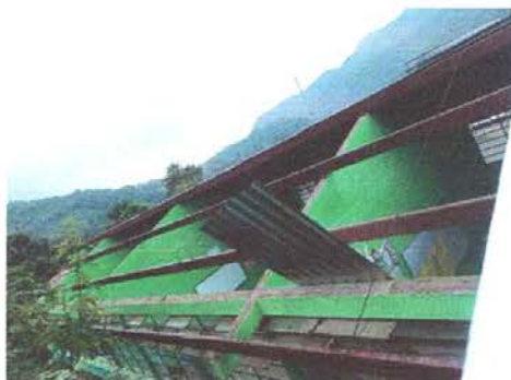
Foto 1: Sustitución de lámina por lámina troquelada aluzinc calibre 26 y sustitución de capote
