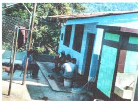
Foto 2: Pintura en muros exteriores e interiores.
