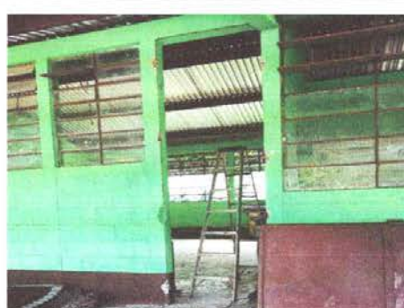
Foto 4: Sustitución de puerta
