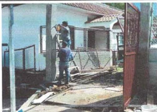
Foto 3: Sustitución de portón de metal
