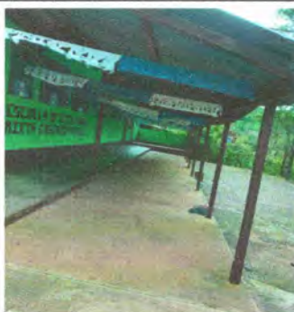
Foto 5: Estructura de techo: Sustitución de estructura de soporte de madera por metal.
