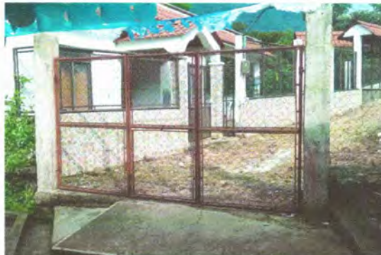
Foto 4: Puerta de metal: sustitución de portón de metal
