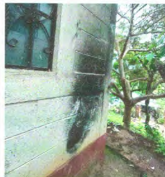
Foto 2: Pintura en muros exteriores e interiores.
