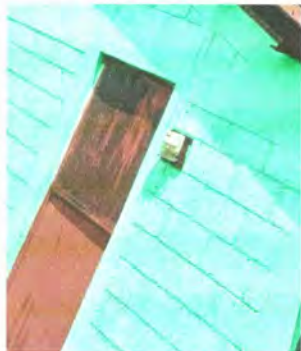
Foto 1: Sustitución de puerta
