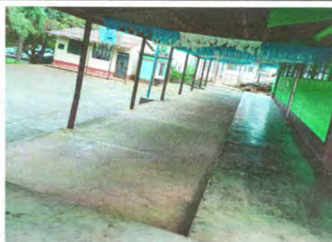
Foto 6: Estructura de techo: Sustitución de estructura de soporte de madera por metal.
