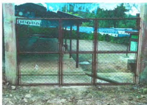
Foto 3: Puerta de metal: sustitución de portón de metal
