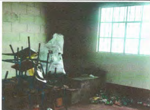
Foto 1: Pintura en muros exteriores e interiores.
