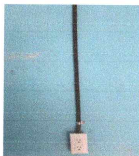
Foto 5: Sustitución de tomacorrientes
