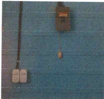
Foto1: Sustitución de interruptores
