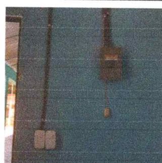
Foto 6: Sustitución de flipón y tablero
