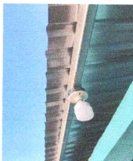
Foto 4: Sustitución de plafoneras
