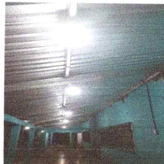
Foto 2: Sustitución de focos ahorradores
