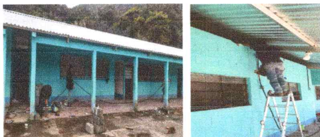
Foto 3:Sustitución de cableado eléctrico
