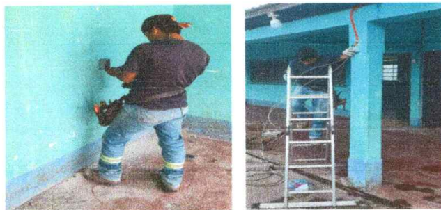
Foto 5: Sustitución de tomacorrientes
