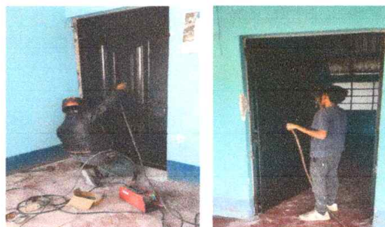
Foto 4:Sustitución de puerta
