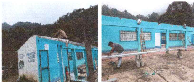
Foto 3:Sustitución de estructura de soporte de madera por metal
