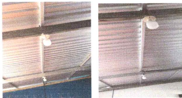
Foto 2:Sustitución de focos ahorradores
