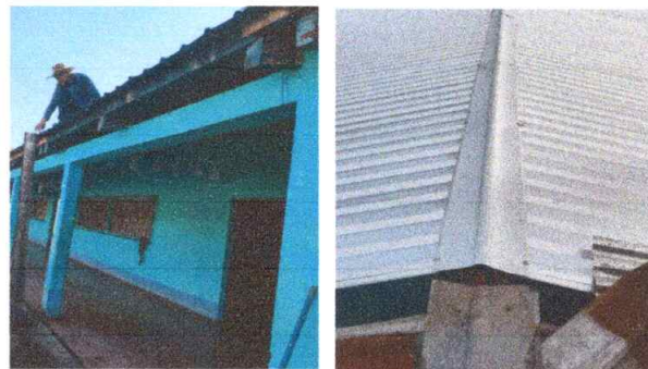
Foto 2:Sustitución de capote de lámina para lámina troquelada
