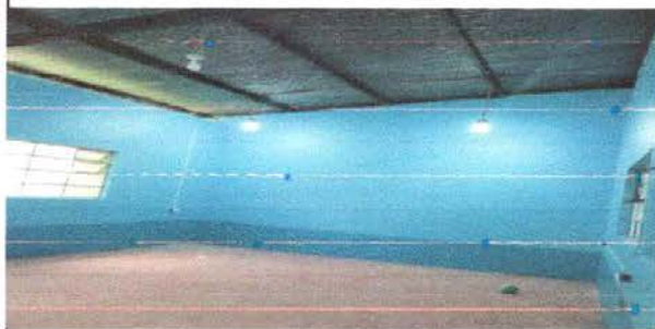
FOTO 13: Sustitución de plafoneras
