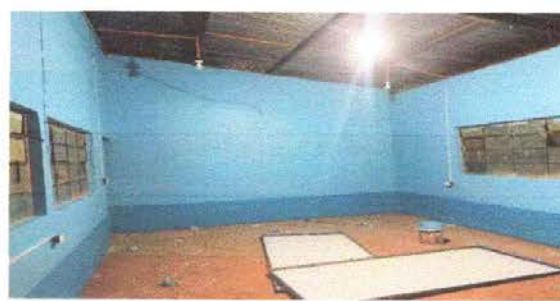
FOTO 18: Sustitución de flexitubo
