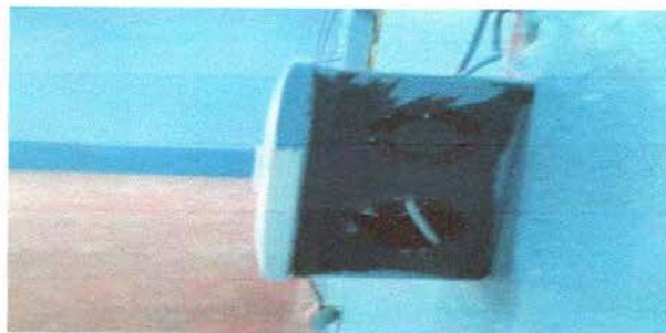
FOTO 16: Sustitución de cajas octagonales
