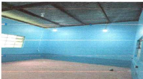
FOTO 14: Sustitución de focos de 40 wats
