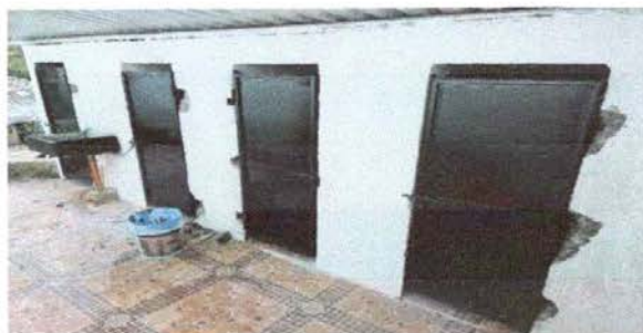
FOTO 3: Sustitución de puertas en servicios sanitarios
