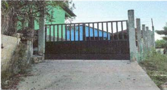
FOTO 8: Sustrucción de portón de metal
