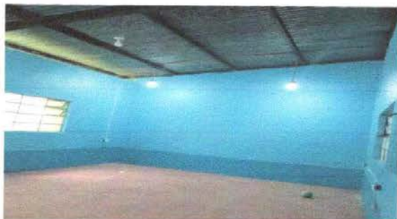
FOTO 20: Sustitución de bombillas
