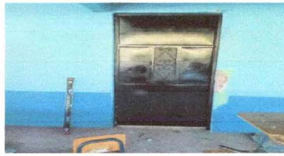
FOTO 2: Mantenimiento a puertas de metal de aulas
