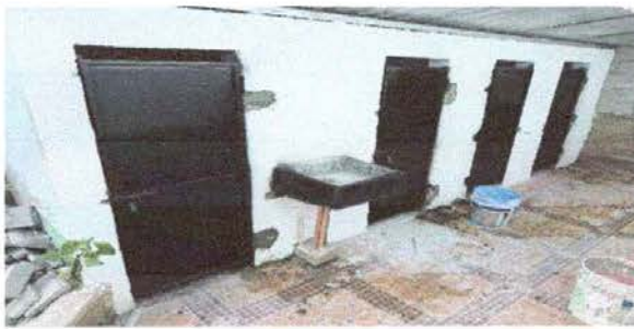
FOTO 3: Sustitución de puertas en servicios sanitarios
