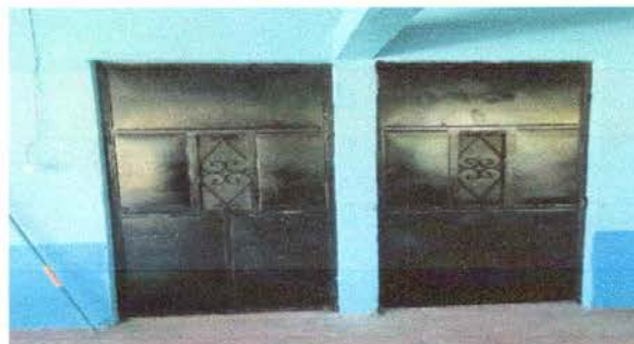
FOTO 2: Mantenimiento a puertas de metal de aulas
