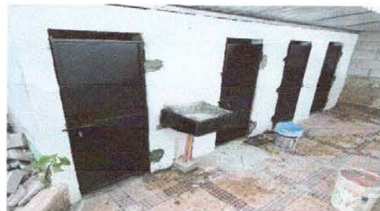
FOTO 7: Sustrucción de lavamanos por lavamanos de concreto
