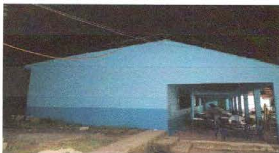
FOTO 18: Sustitución de flexitubo
