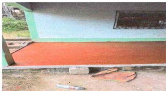
FOTO 4: Reparación de piso de torta
