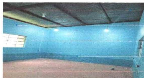
FOTO 15: Sustitución de focos de 20 wats
