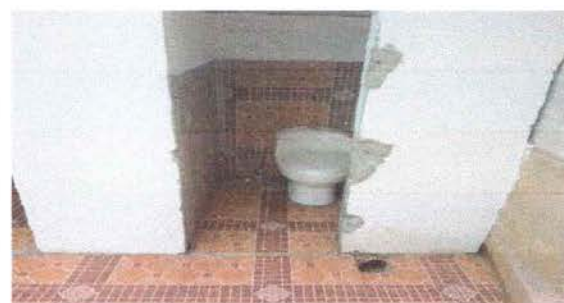
FOTO 6: Sustitución de inodoros
