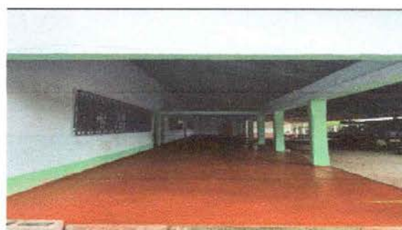
FOTO 4: reparación de piso de torta
