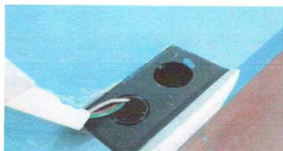
FOTO 17: Sustitución de cajas rectangulares
