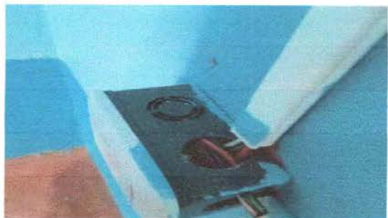
FOTO 17: Sustitución de cajas rectangulares
