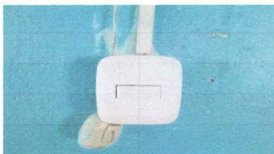
FOTO 11: Sustrucción de apagadores
