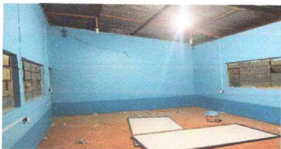
FOTO 19: Sustitución de canaletas eléctricas
