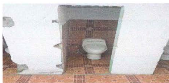
FOTO 6: Sustitución de inodoros
