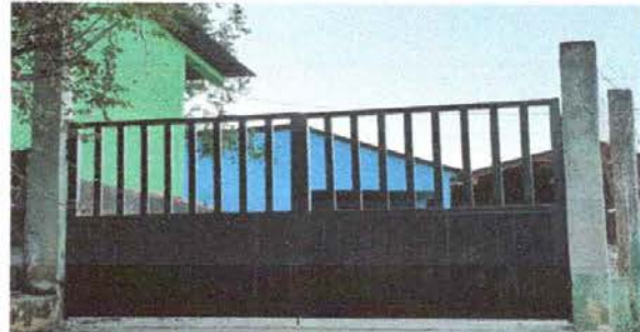
FOTO 8: Sustrucción de portón de metal
