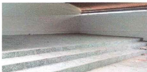
FOTO 5: Sustitución de piso de concreto por piso de granito
