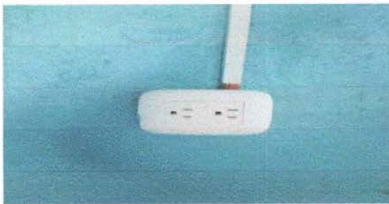
FOTO 12: Sustrucción de tomacorrientes
