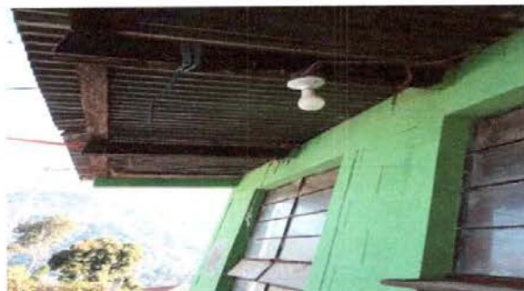
FOTO 20: Sustitución de bombillas
