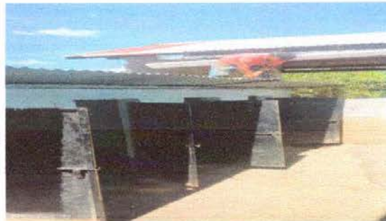
FOTO 1: Sustitución de lámina y estructura de soporte de madera por metal
