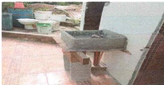
FOTO 7: Sustitución de lavamanos por lavamanos de concreto
