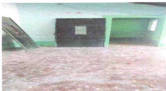
FOTO 2: Mantenimiento a puertas de metal de aulas
