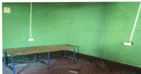
FOTO 19: Sustitución de canaletas eléctricas
