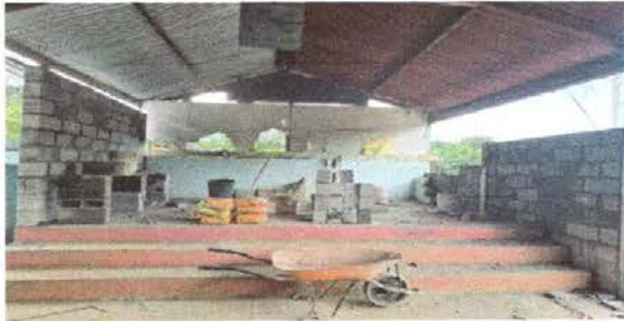
FOTO 5: Sustitución de piso de concreto por piso de granito
