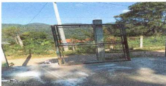
FOTO 8: Sustitución de portón de metal
