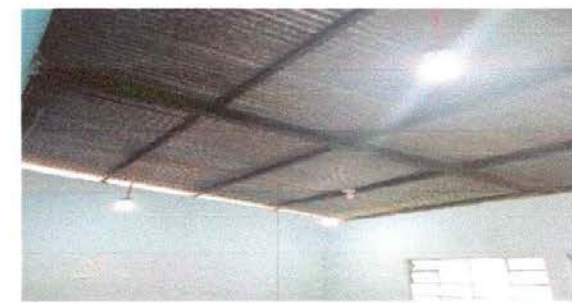
FOTO 15: Sustrucción de focos de 20 wats
