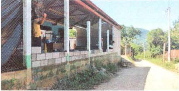
FOTO 25: Sustrucción de maya por block en una parte del área externa del establecimiento educativo
