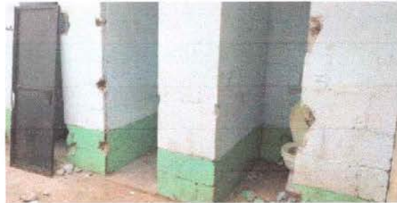
FOTO 6: Sustitución de inodoros
