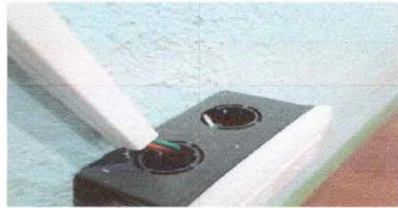
FOTO 17: Sustitución de cajas rectangulares
