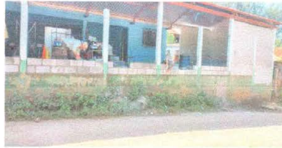
FOTO 25: Sustrucción de maya por block en una parte del área externa del establecimiento educativo
