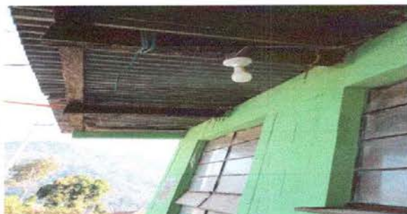
FOTO 14: Sustrucción de focos de 40 wats
