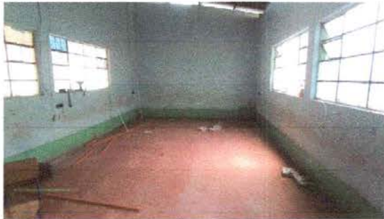
FOTO 26: Pintura en dos aulas y área externa del establecimiento educativo
