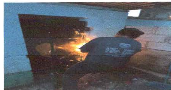
FOTO 3: Sustitución de puertas en servicios sanitarios
