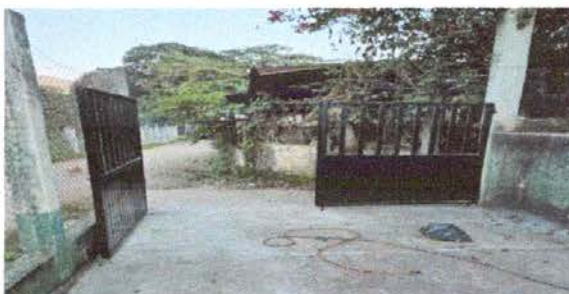
FOTO 8: Sustitución de portón de metal
