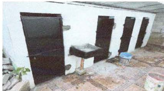
FOTO 7: Sustitución de lavamanos por lavamanos de concreto
