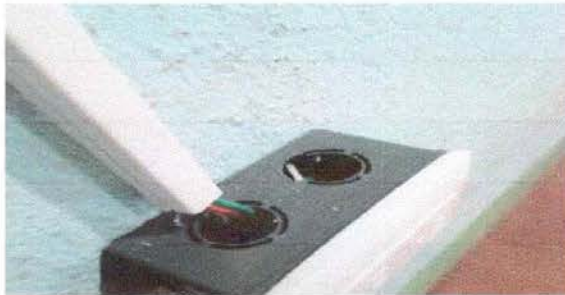
FOTO 17: Sustitución de cajas rectangulares
