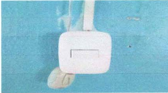
FOTO 11: Sustrucción de apagadores
