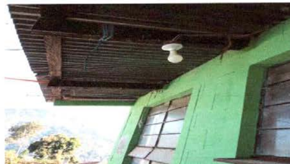
FOTO 20: Sustitución de bombillas
