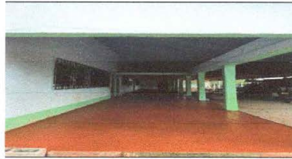
FOTO 26: Pintura en dos aulas y área externa del establecimiento educativo
