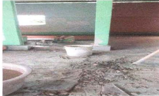
FOTO 4: reparación de piso de torta
