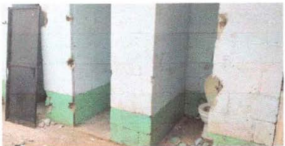
FOTO 3: Sustitución de puertas en servicios sanitarios
