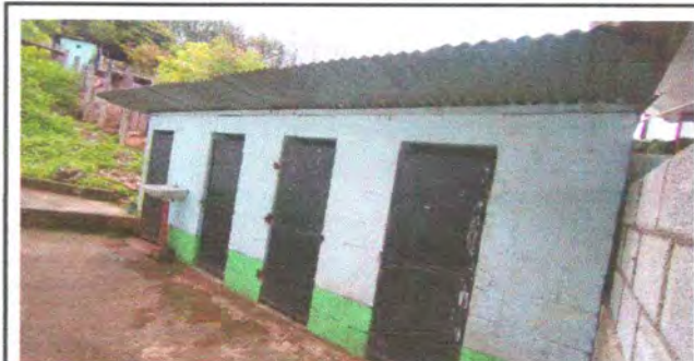
FOTO 3: Sustitución de puertas en servicios de baños
