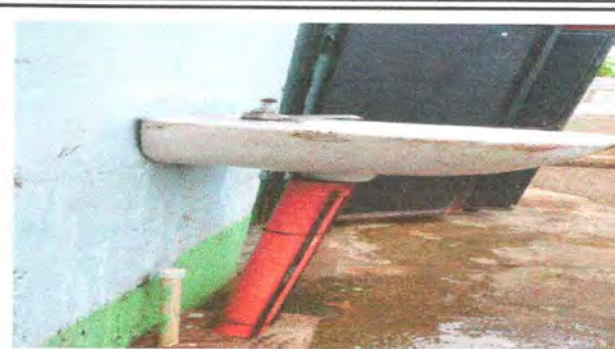
FOTO 7: Sustitución de lavamanos por lavamanos de concreto
