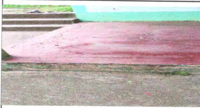
FOTO 4: Reparación de piso de torta
