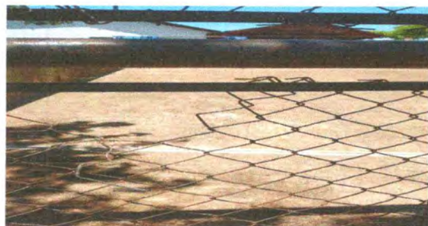
FOTO 8: Sustitución de portón de metal
