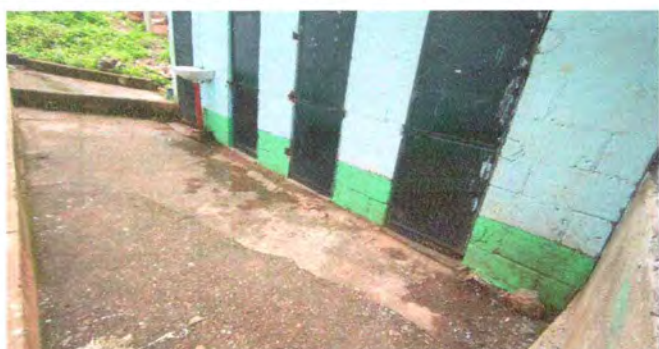
FOTO 11: Reparación de piso de torta
