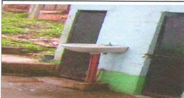
FOTO 7: Sustitución de lavamanos por lavamanos de concreto
