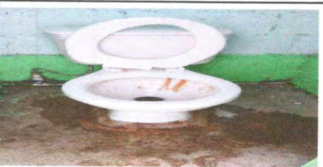
FOTO 6: Sustitución de inodoros
