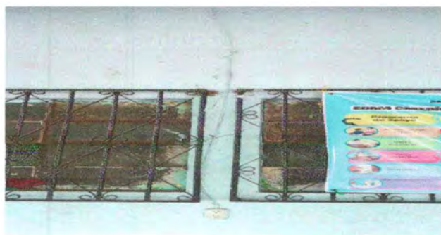
FOTO 16: Sustitución de tomacorrientes
