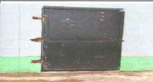
FOTO 3: Sustitución de puertas en servicios de baños
