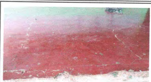
FOTO 4: reparación de piso de torta
