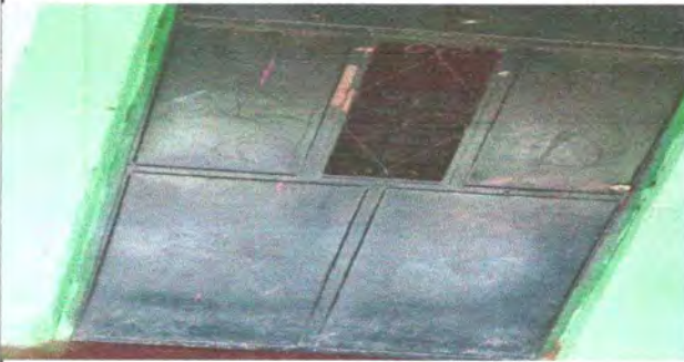
FOTO 2: Sustitución de puertas
