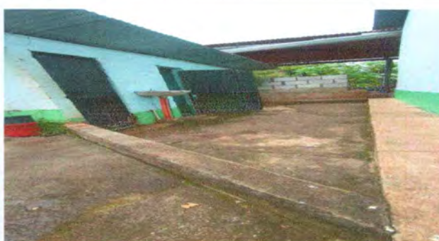
FOTO 11: Reparación de piso de piso de torta
