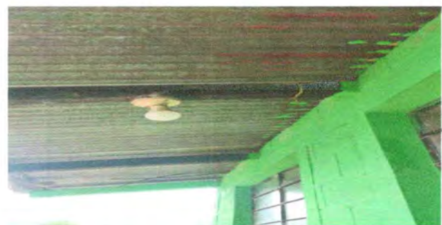
FOTO 17: Sustitución de plafoneras
