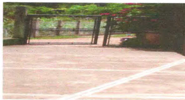
FOTO 8: Sustitución de portón de metal
