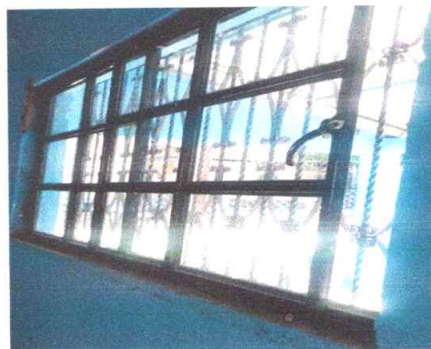
Foto 4: Sustrucción de ventanas de metal por metal más vidrio
