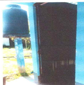
Foto 10: Sustitución de puertas
