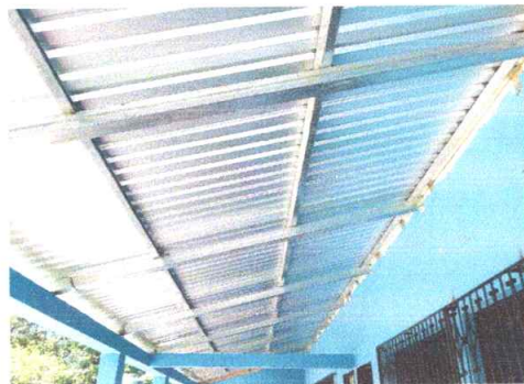
Foto 8: Sustitución de estructura de soporte de madera por metal
