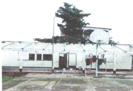
Foto7: Sustitución de estructura de soporte de madera por metal
