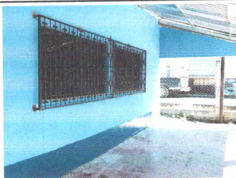
Foto 5: Sustrucción de balcones de metal
