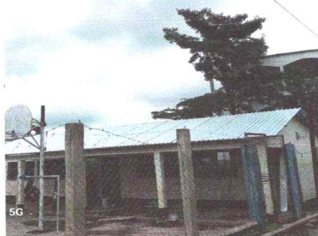
Foto 2: Sustrucción de lámina, por lámina troquelada aluzinc calibre 26
