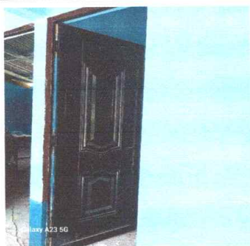
Foto 9: Sustitución de puertas
