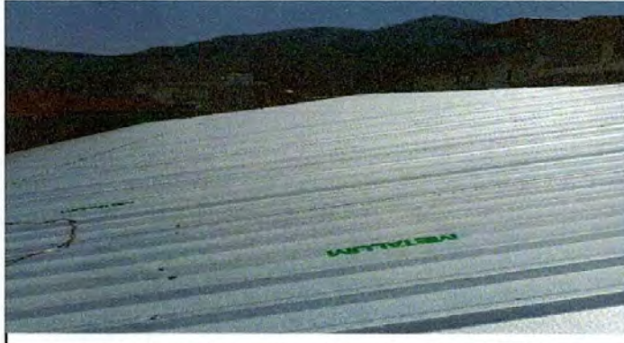
Foto1: Sustrucción de lámina
