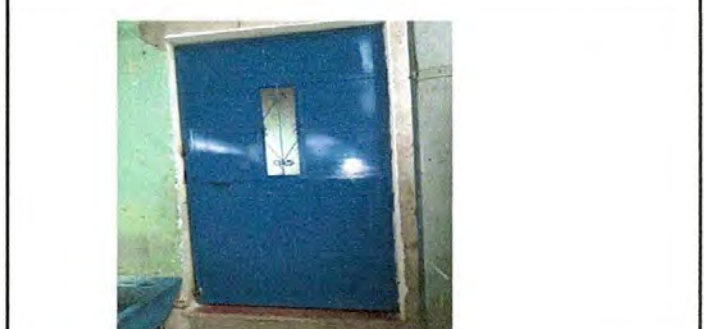
Foto 6: Sustrucción de puertas de metal
