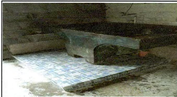
Foto 3: Sustrucción de elementos de fijación de pila
