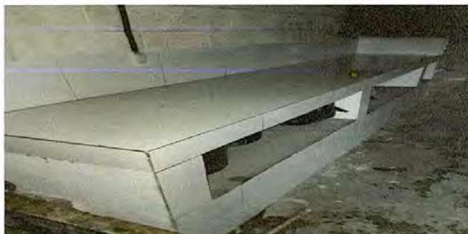
Foto 8: Sustitución de desayunador
