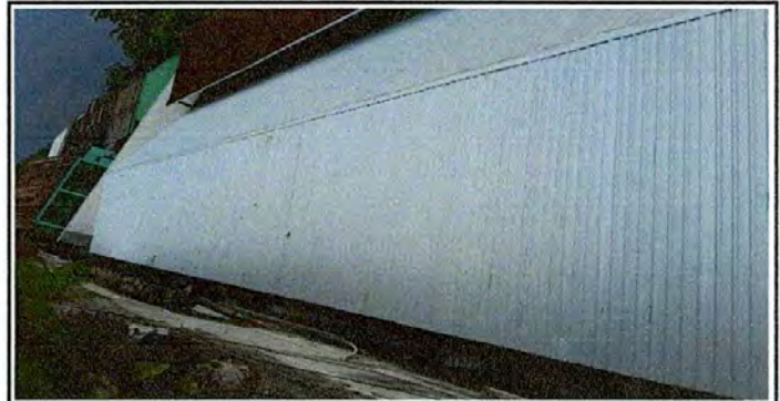
Foto 2: Sustrucción de capotes de lámina
