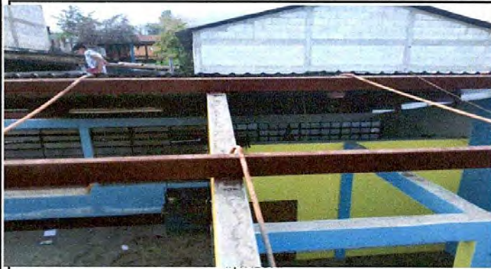
Foto1: Sustrucción de lámina
