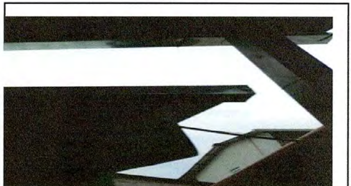
Foto 4: sustitución de canales
