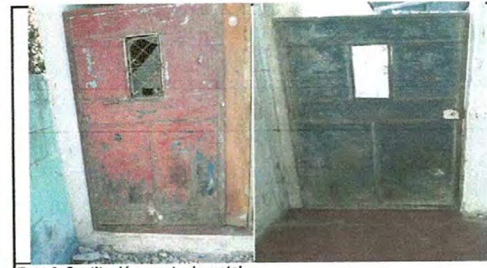
Foto 6. Sustitución puerta de metal
