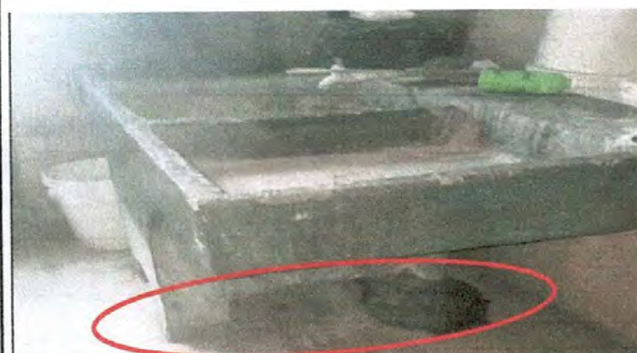
Foto 3. Sustitución de elementos de fijación de pila
