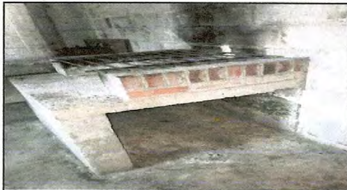
Foto 7. Sustitución estufa rural.
