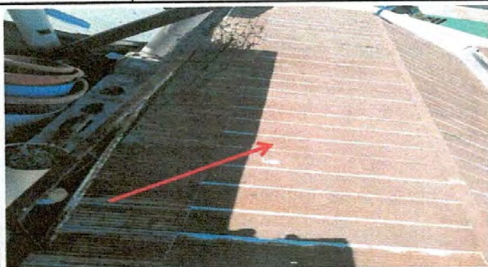
Foto 1. Sustitución de lámina.
