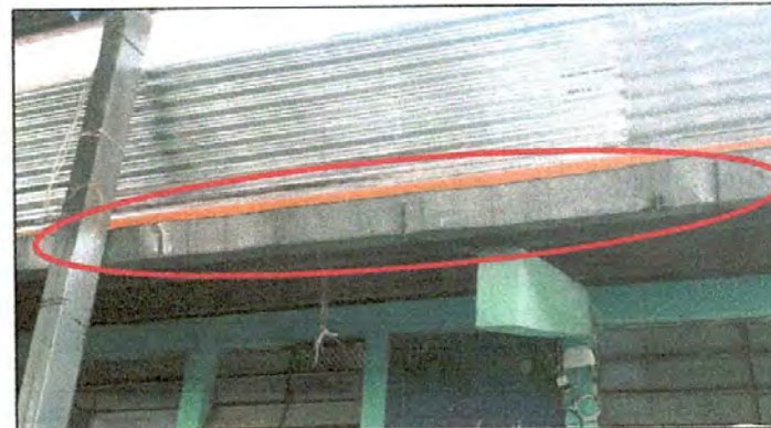
Foto 4. Sustitución de canal de metal.
