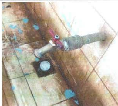
Foto 11: Sustitución de llave de chorro
