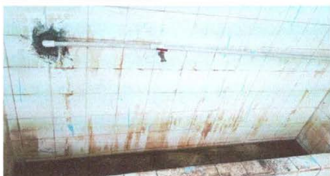
Foto 9: Sustitución de llave de mingitorio
