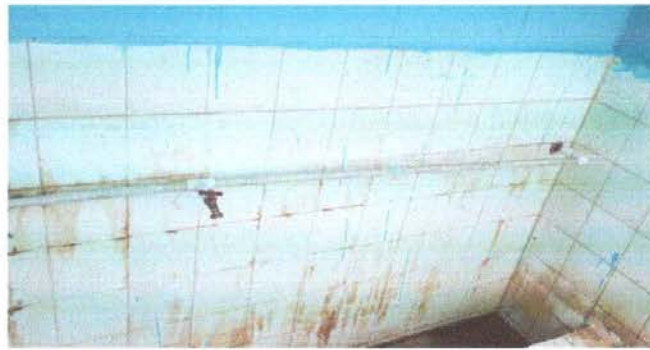
Foto 10: Sustitución de llave de mingitorio
