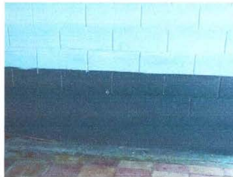
Foto 8: Pintura de muros exteriores e interiores
