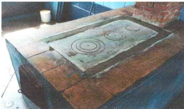
Foto 1: Sustrucción de plancha de metal de 3 hornillas
