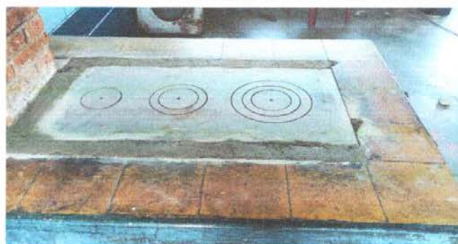
Foto 2: Sustrucción de plancha de metal de 3 hornillas
