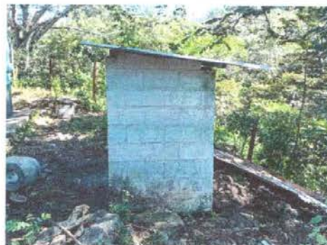
Foto 14. Sustitución de techo de baños de madera de metal
