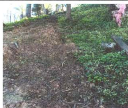
Foto 6: Sustrucción de tubería PVC línea principal aguas negras más accesorios
