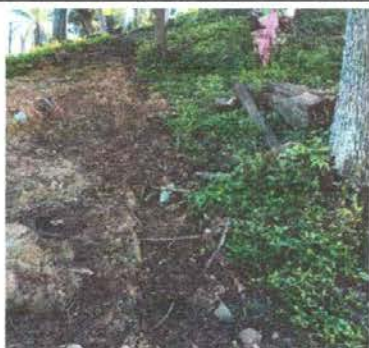
Foto 5: Sustrucción de tubería PVC línea principal aguas negras más accesorios
