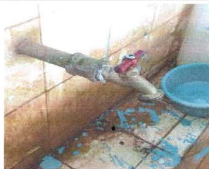
Foto 12: Sustitución de llave de chorro
