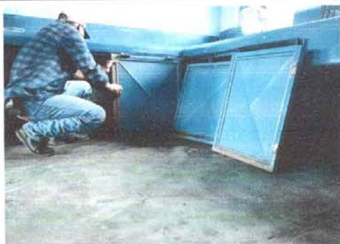
Foto 17: Sustitución de puerta de metal de gabinetes de cocina
