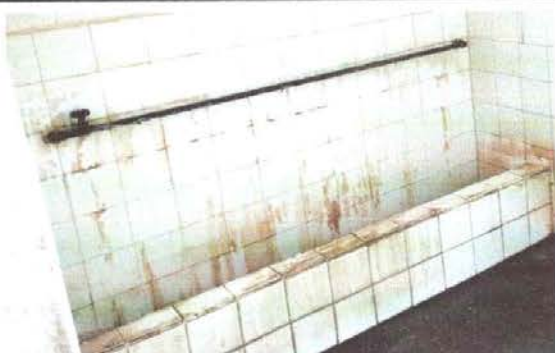
Foto 9: Sustitución de llave de mingitorio
