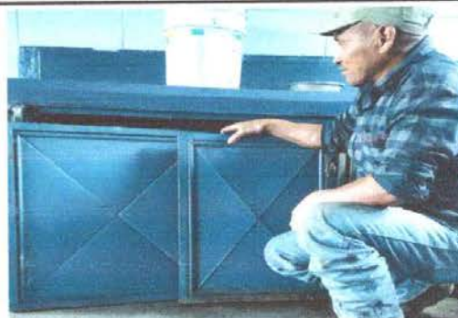
Foto 18: Sustitución de puerta de metal de gabinetes de cocina
