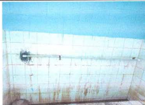
Foto 10: Sustitución de llave de mingitorio
