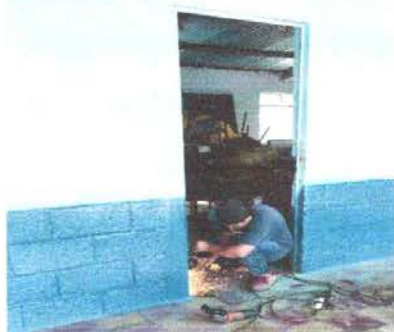
Foto 15: Fabricación e instalación de puertas de metal en aulas
