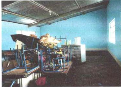
Foto 8: Pintura de muros exteriores e interiores
