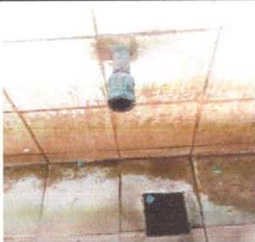
Foto 11: Sustitución de llave de chorro
