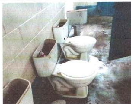
Foto 4: Sustitución de inodoro
