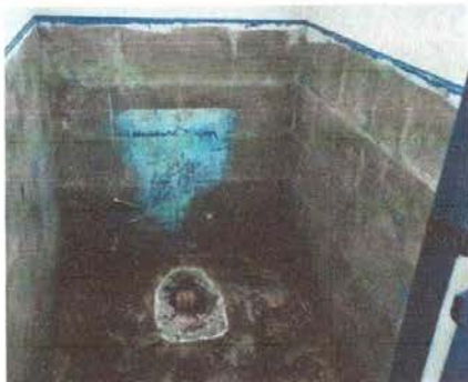
Foto 3: Sustitución de inodoro
