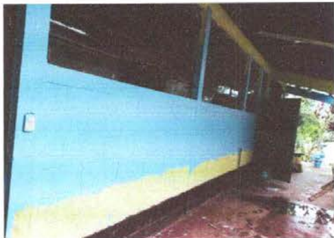
Foto 7: Pintura de muros exteriores e interiores
