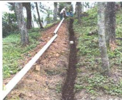
Foto 6: Sustitución de tubería PVC línea principal aguas negras más accesorios
