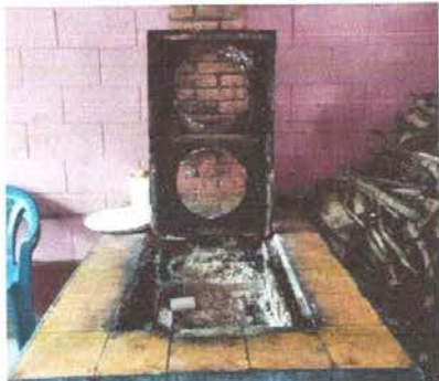
Foto 1: Sustitución de plancha de metal de 3 hornillas
