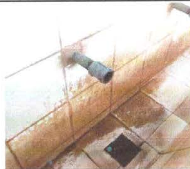
Foto 12: Sustitución de llave de chorro
