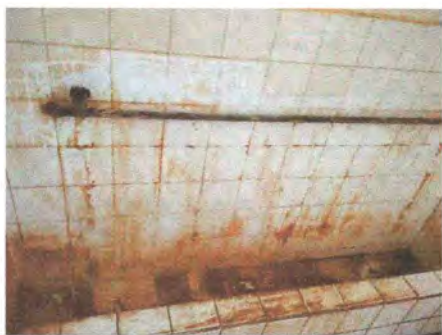
Foto 9: Sustitución de llave de mingitorio
