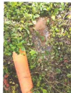
Foto 6: Sustitución de tubería PVC línea principal aguas negras más accesorios
