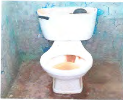
Foto 3: Sustitución de inodoro
