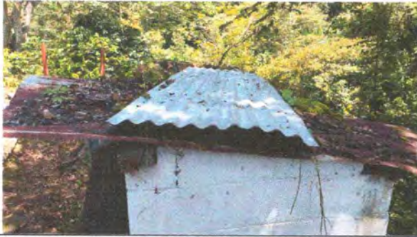
Foto 13: Sustrucción de techo de baños de madera por metal
