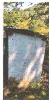
Foto 14: Sustrucción de techo de baños de madera por metal
