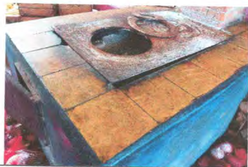
Foto 2: Sustitución de plancha de metal de 3 hornillas
