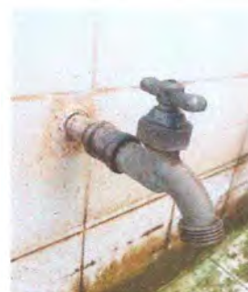
Foto 12: Sustitución de llave de chorro
