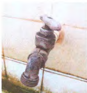
Foto 11: Sustitución de llave de chorro
