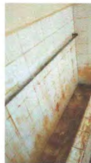
Foto 10: Sustitución de llave de mingitorio
