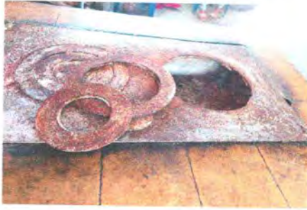
Foto 1: Sustitución de plancha de metal de 3 hornillas
