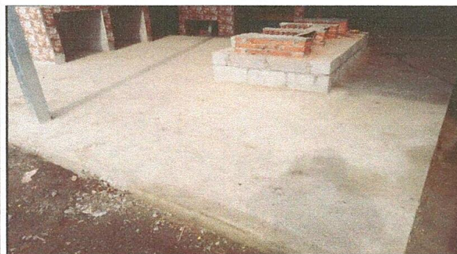
FOTO 3: SUSTITUCIÓN DE PISO TORTA DE CEMENTO
