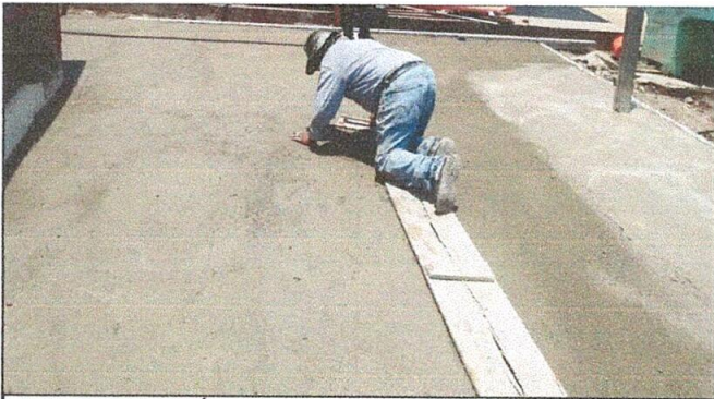
FOTO 3: SUSTITUCIÓN DE PISO TORTA DE CEMENTO
