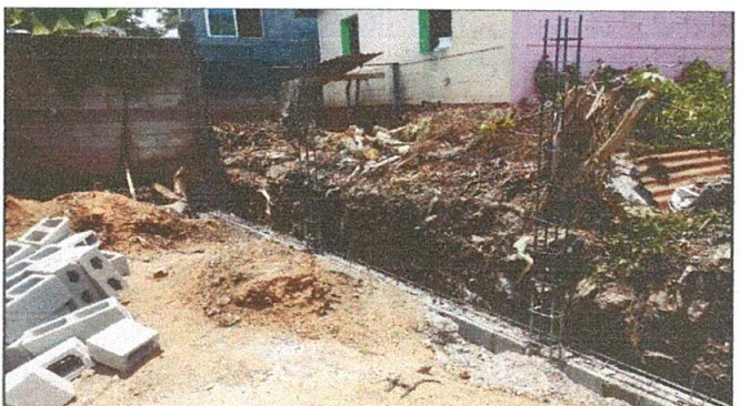
FOTO 4: SUSTITUCIÓN MURO PERIMETRAL
