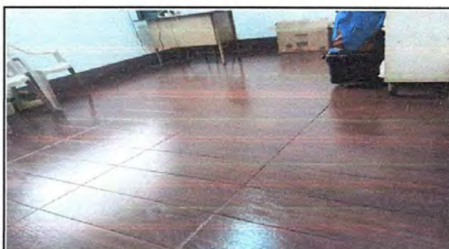
Sustitución de piso de torta de concreto por cerámico
