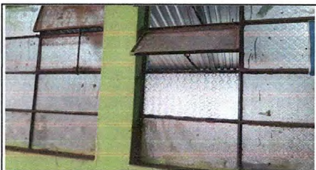
Sustitución de vidrios
