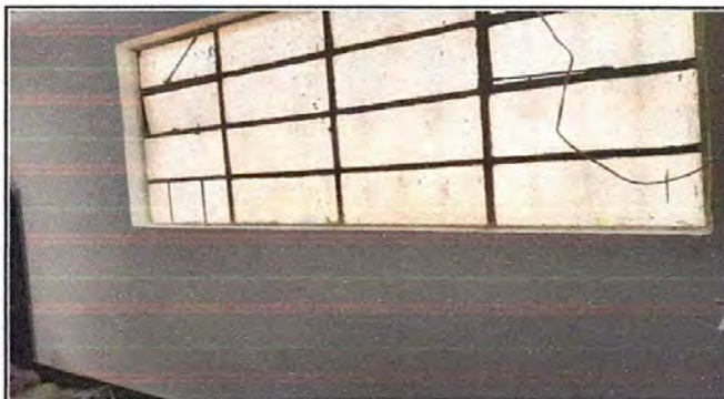
Repello en muro
