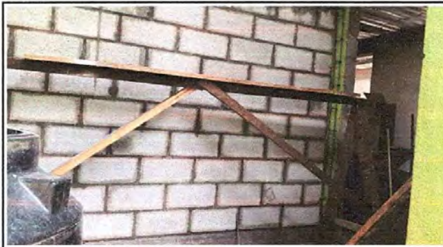
Mejoramiento de pared división de cocina
