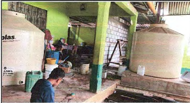
Sustitución de depósito de agua 2500 lts
