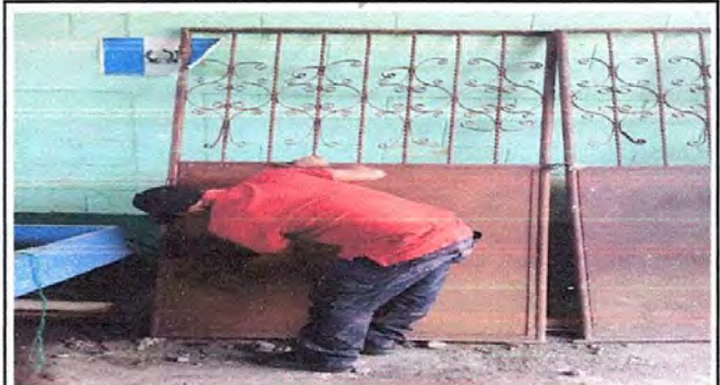
Mantenimiento a portón de metal
