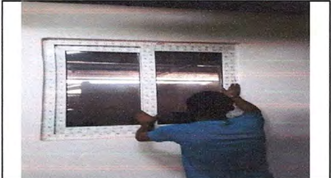
Fabricación e instalación de ventana
