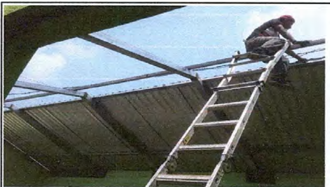
Sustitución de elementos de fijación
