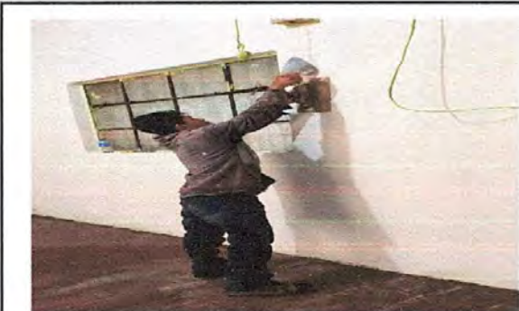
Repello en muro
